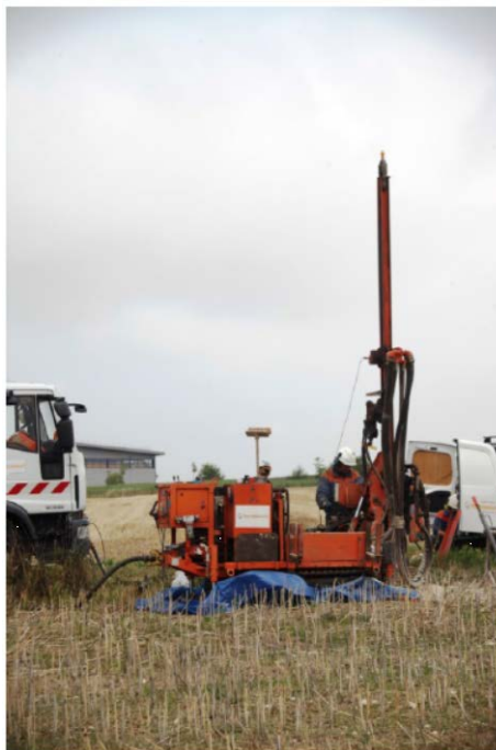
図 3.1-8 建設用地での掘削
