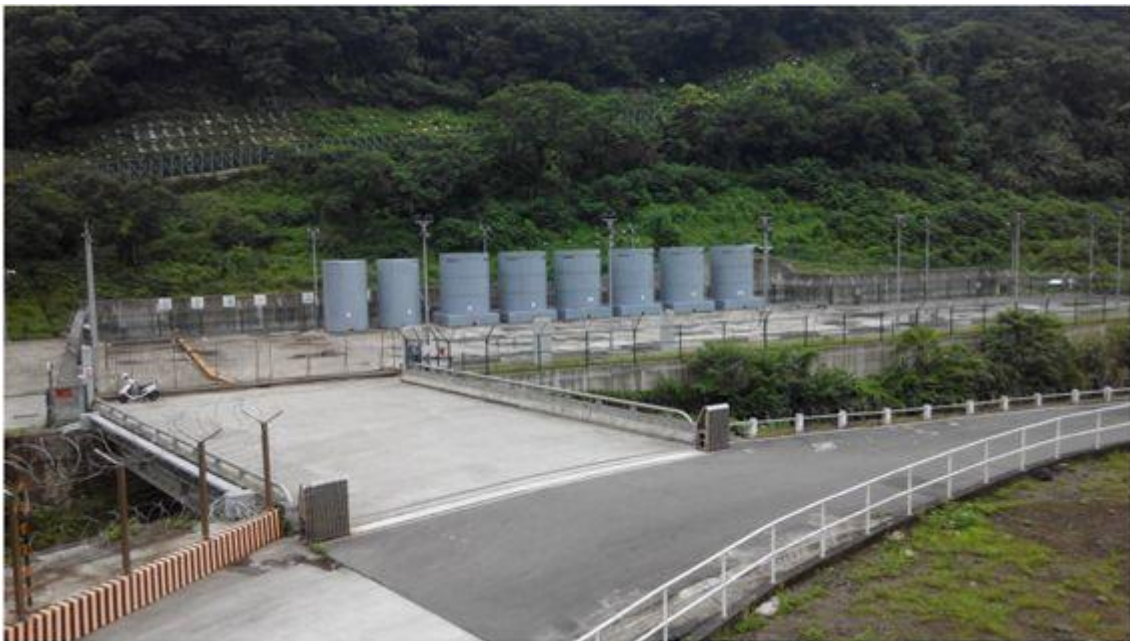
図 3.1-7 第 1 原子力発電所の乾式貯蔵施設の側景
