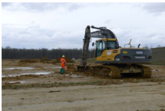
図 3.1-1 Cires の第 2 工期の施工写真
