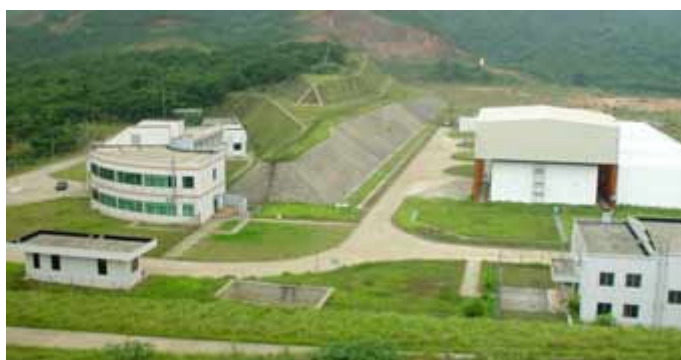
図 2.3-2 広東（北龍）低中レベル放射性廃棄物処分場《23》
