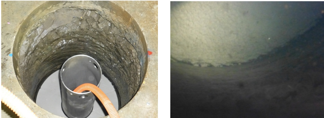
図 12.4.1-2 緩衝材ブロック 1 段のみ設置し、地下水流入量 (7L/分→2L/分)
