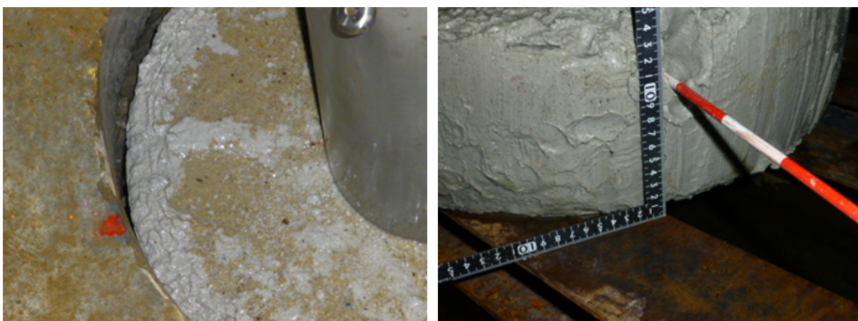
図 12.4.1-4 試験孔 3 における緩衝材ブロックのみの取り出し状況
