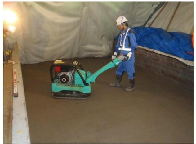
図 3.1-41 バイブロコンパクタによる転圧状況
