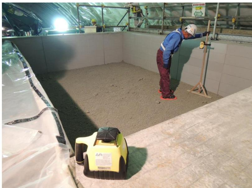
図 2.1-29 レーザーレベルによる敷均し厚さの管理状況
