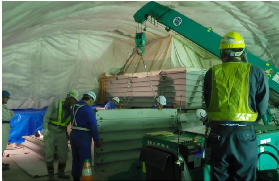
図 2.1-23 緩衝材鋼製型枠設置状況
