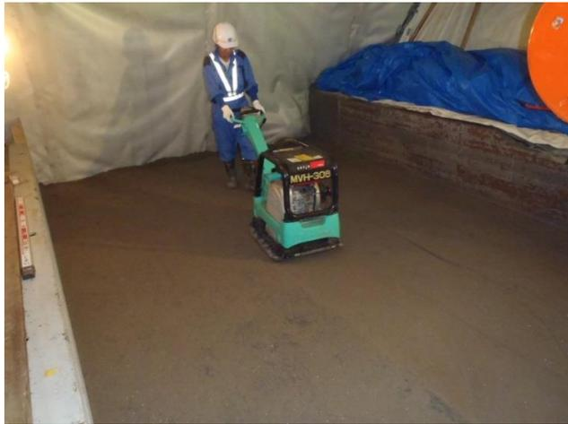
図 3.1-40 バイブロコンパクタによる転圧状況
