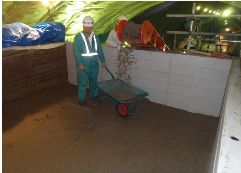
図 3.1-35 材料運搬状況（猫車使用）
