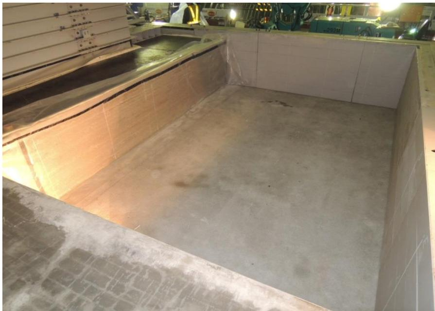
図 2.1-24 鋼製型枠設置後の内部状況
