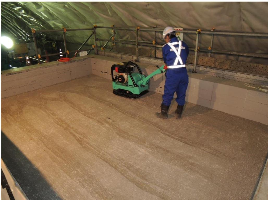
図 2.1-33 バイブロコンパクタによる予備転圧状況
