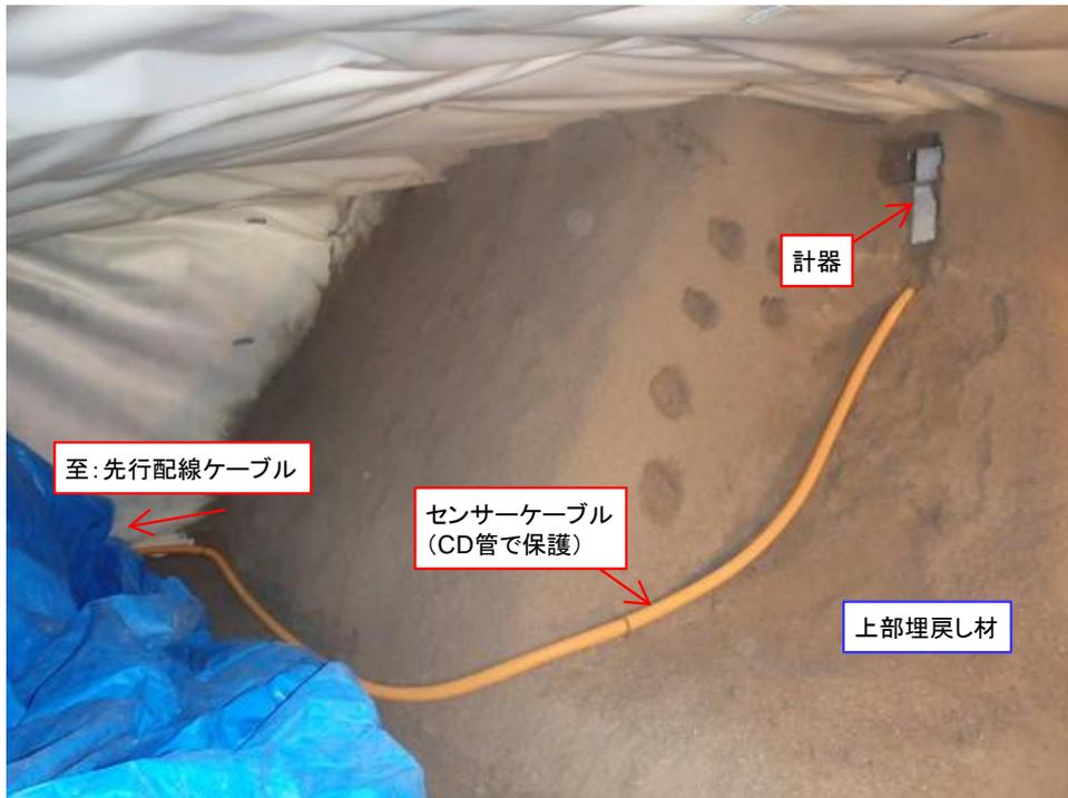
図 6.2-5 計器設置写真 (吹付け前)
