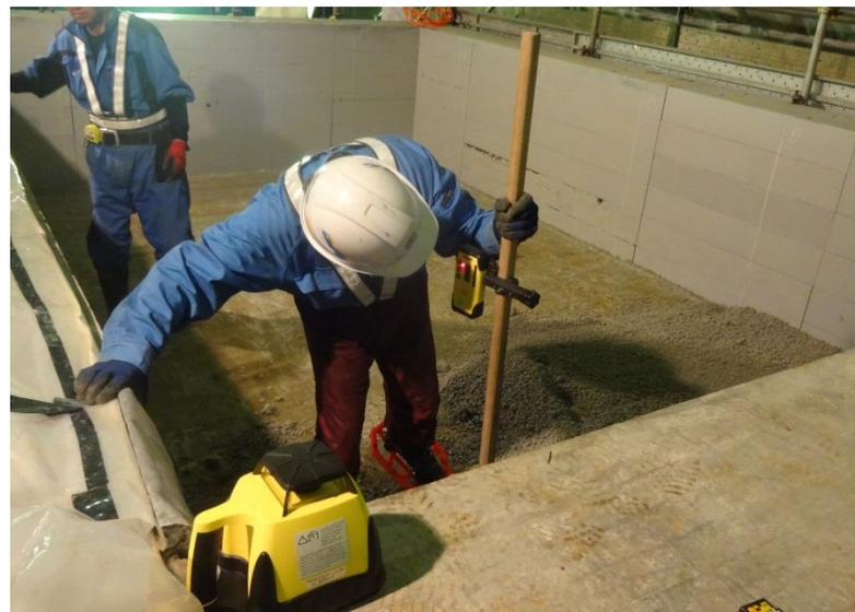
図 3.1-37 レーザーレベルによる敷均し厚管理状況
