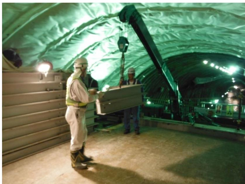
図 3.1-29 埋戻し材鋼製型枠設置状況
