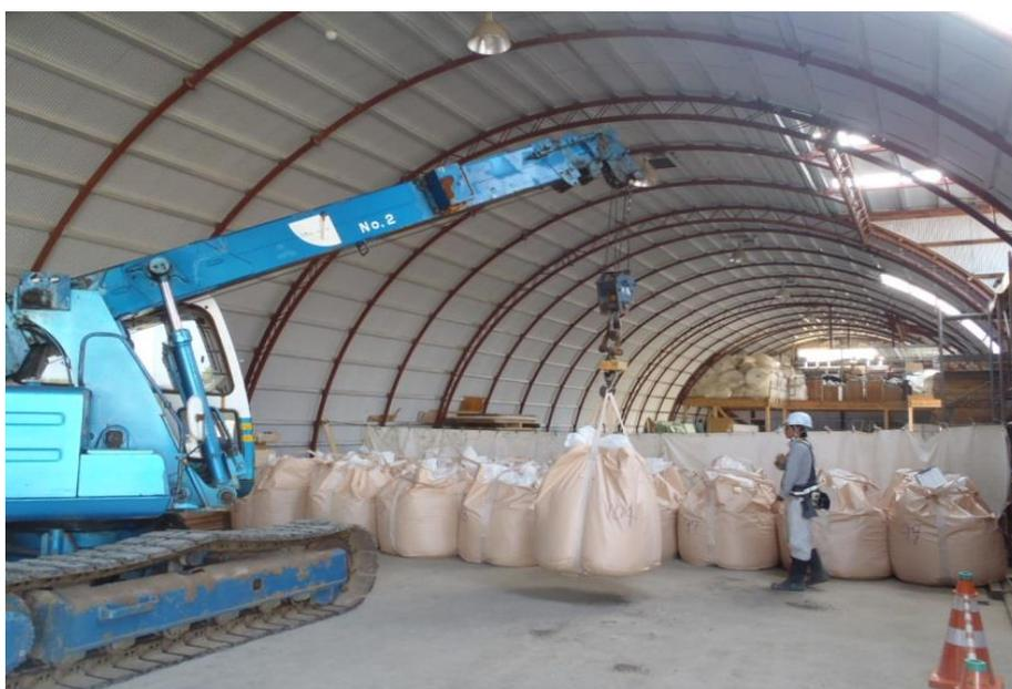
図 3.1-18 混合土の倉庫への一時保管状況
