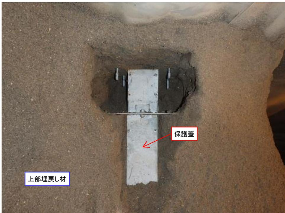
図 6.2-4 計器設置写真 (保護蓋取付後)
