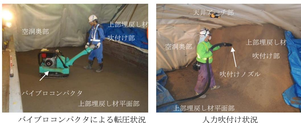
図 1.3-2 上部埋戻し材施工確認試験状況
