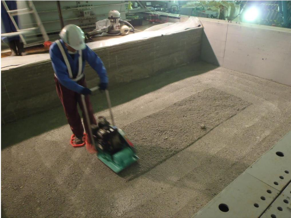
図 2.1-32 プレートコンパクタによる予備転圧状況
