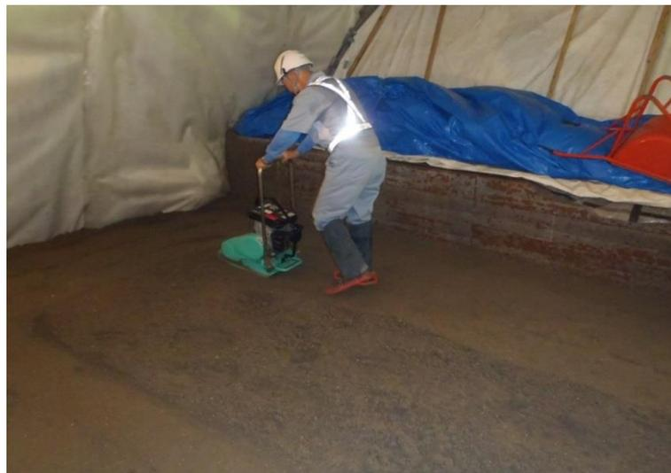
図 3.1-39 プレートコンパクトによる転圧状況
