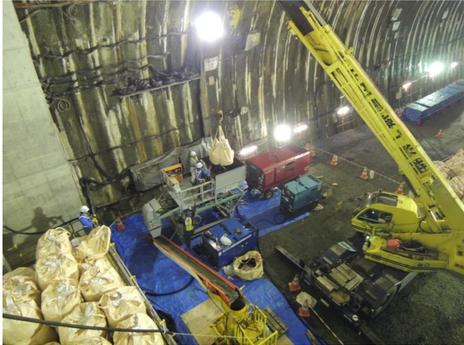
図 3.1-48 供給機への材料投入状況
