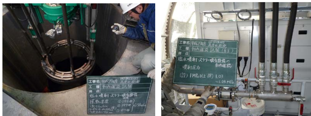
図 2.1.5-8 塩水噴射・スラリー吸引装置の動作確認試験状況
