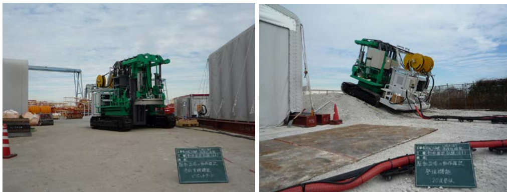
図 2.1.5-2 走行装置の動作確認試験状況
