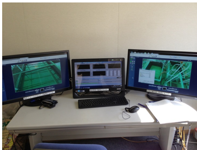
図 2.1.8-17 塩水リユース設備の監視状況
