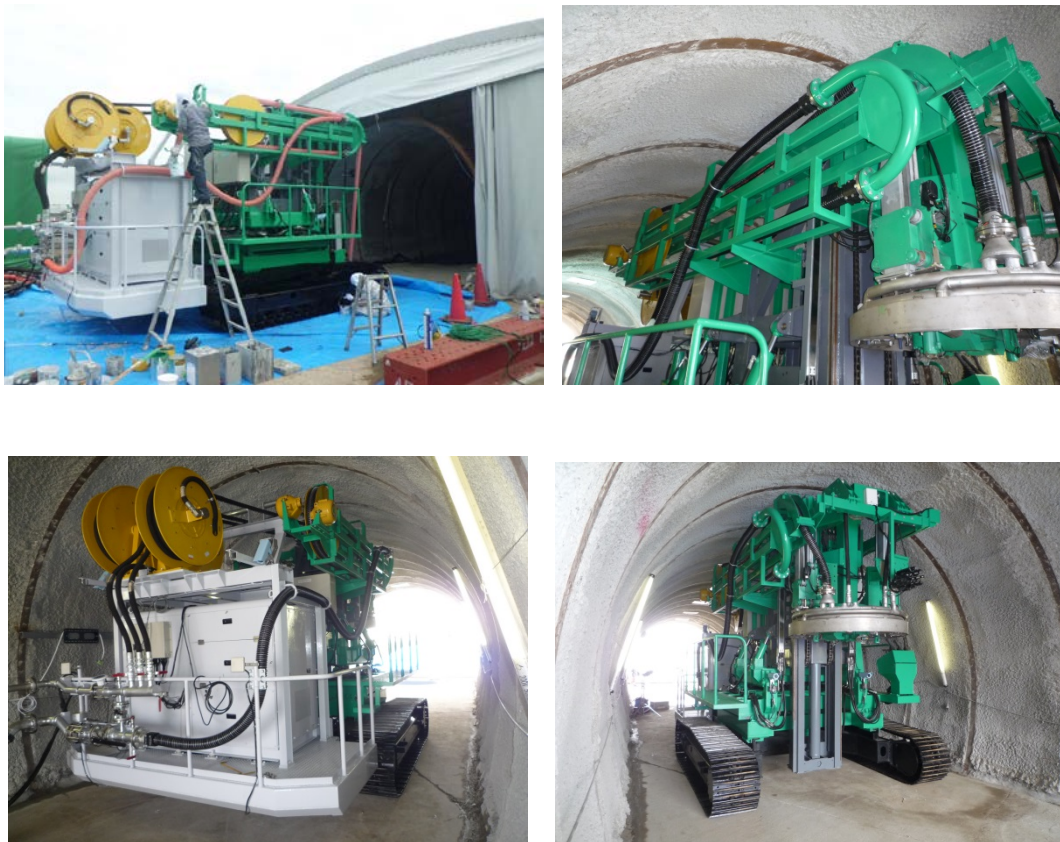
図 2.1.2-8 昇降装置の製作状況
