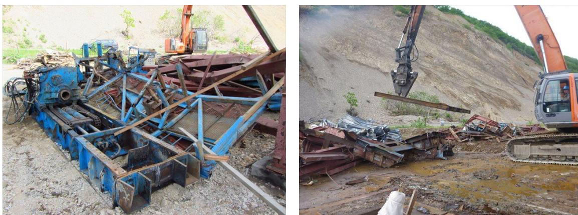
図 5.1.5-1 試錐機本体・マスト基礎鋼解体撤去状況
