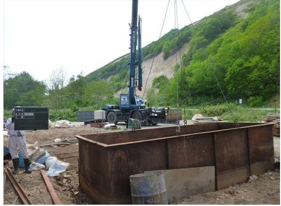
図 5.1.1-3 現場事務所解体ならびに鋼製タンク撤去状況
