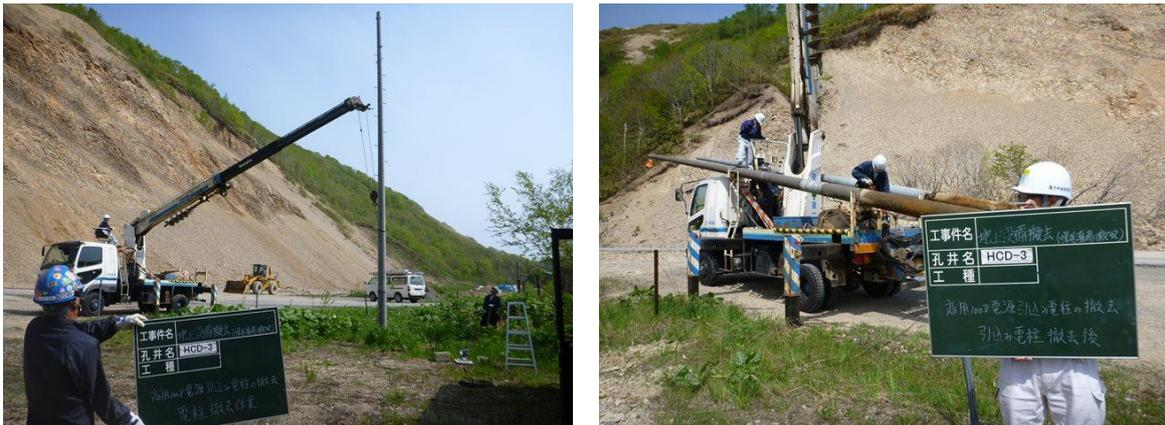
図 5.1.1-1 引き込み電柱撤去作業
