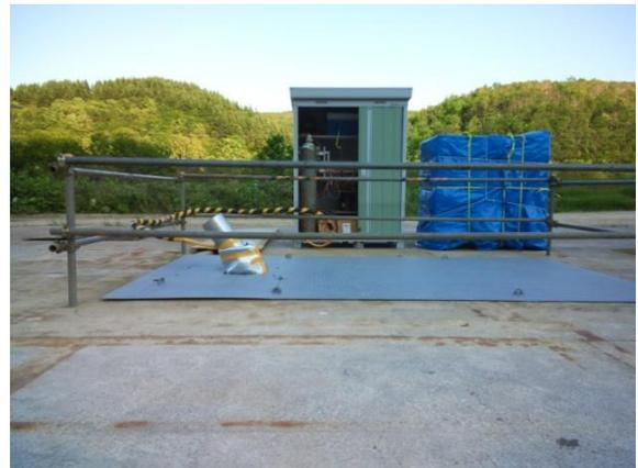
図 5.1.6-2 孔口部鋼製蓋設置作業状況およびモニタリング計測システム復旧状況
