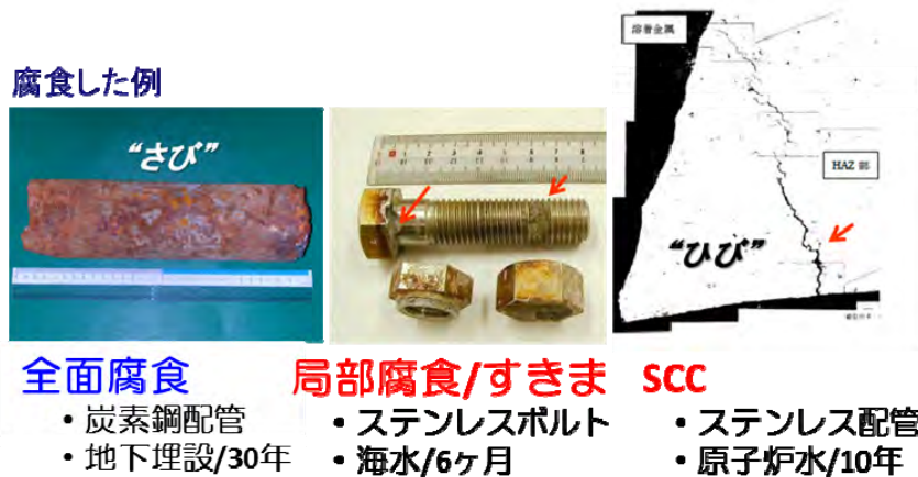
(c) 腐食損傷の例
