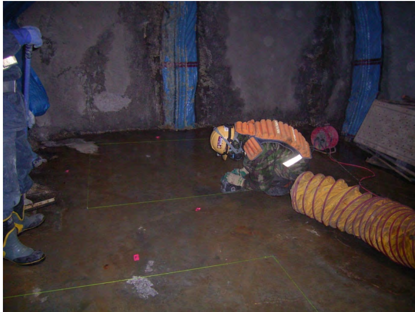
図 11.1.5-3 既設コンクリート切断状況（コンクリートカッター使用）
