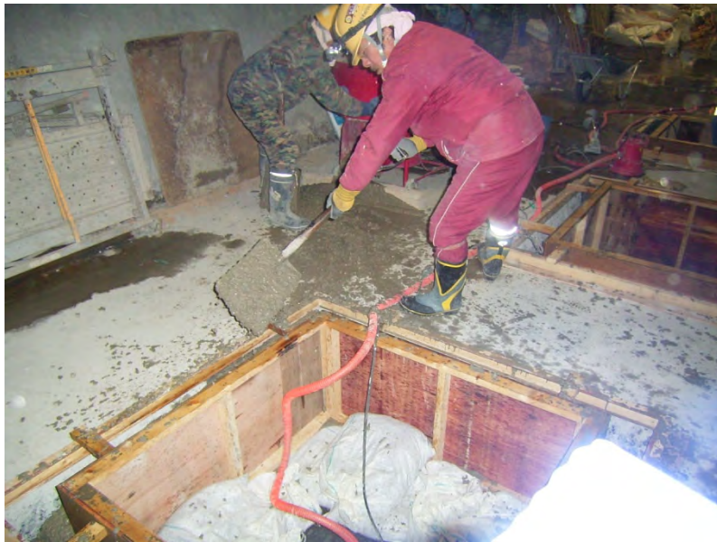
図 11.1.5-12 コンクリート打設③ (コンクリート型枠内投入)
