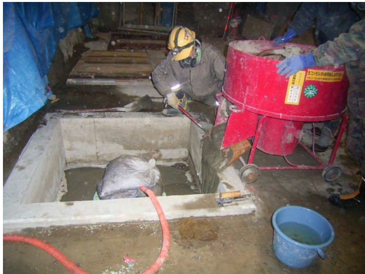
図 11.1.5-16 無収縮モルタル打設状況
