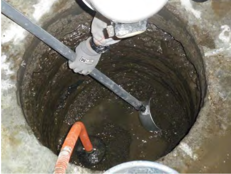
図 11.1.5-19 底盤スライム除去状況
