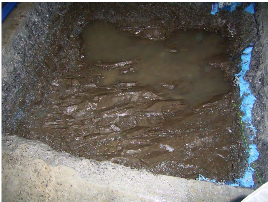
図 11.1.5-6 掘削ガラ・浮石除去完了
