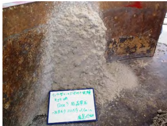
図 9.3.2-24 吹付け後の施工部 (Case3)
