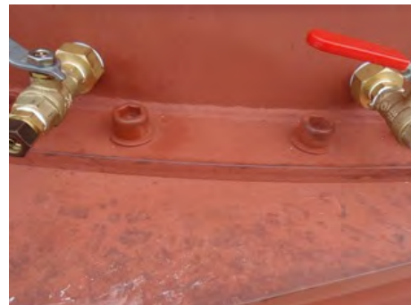
図 9.3.3-3 底板と側壁の剛結箇所
