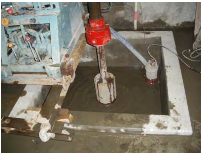
図 11.1.5-18 削孔状況（ピット内）
