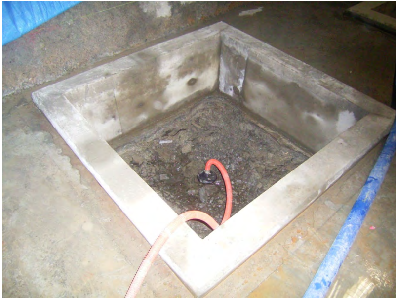
図 11.1.5-15 孔壁保護コンクリート打設完了
