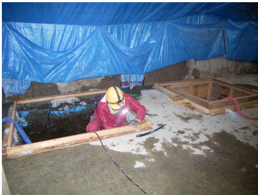
図 11.1.5-8 型枠設置状況
