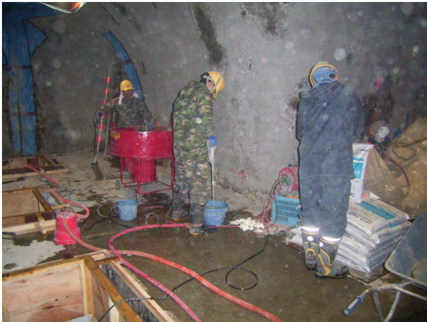
図 11.1.5-10 コンクリート打設① (材料練混ぜ)
