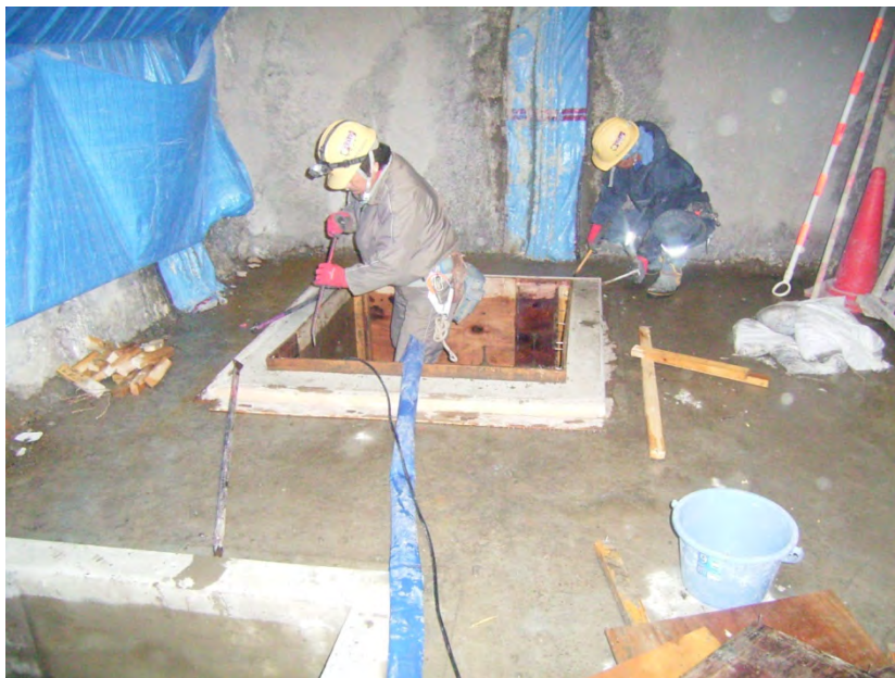
図 11.1.5-14 型枠解体
