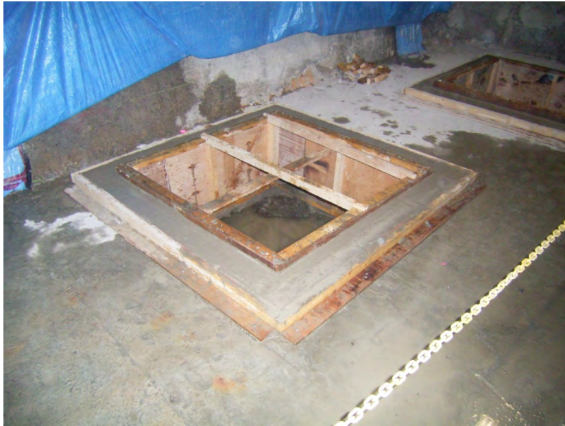
図 11.1.5-13 コンクリート打設完了
