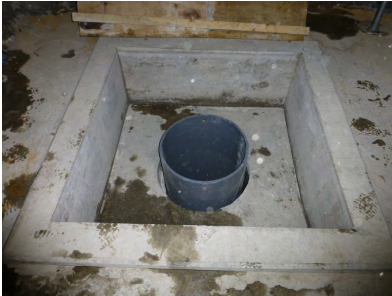
図 11.1.5-21 孔壁保護用の塩ビ管の設置
