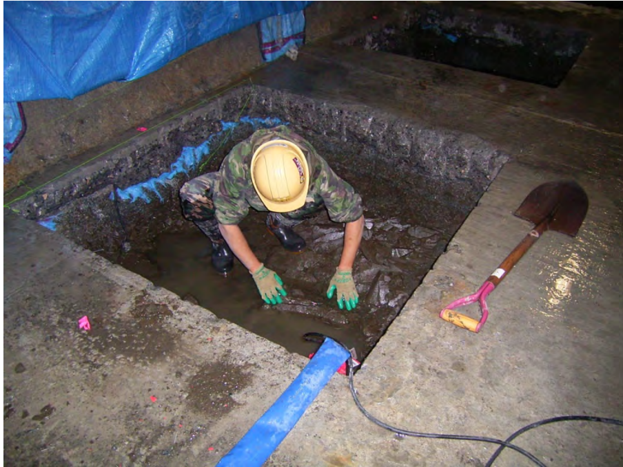
図 11.1.5-5 人力による掘削ガラ・浮石の除去状況
