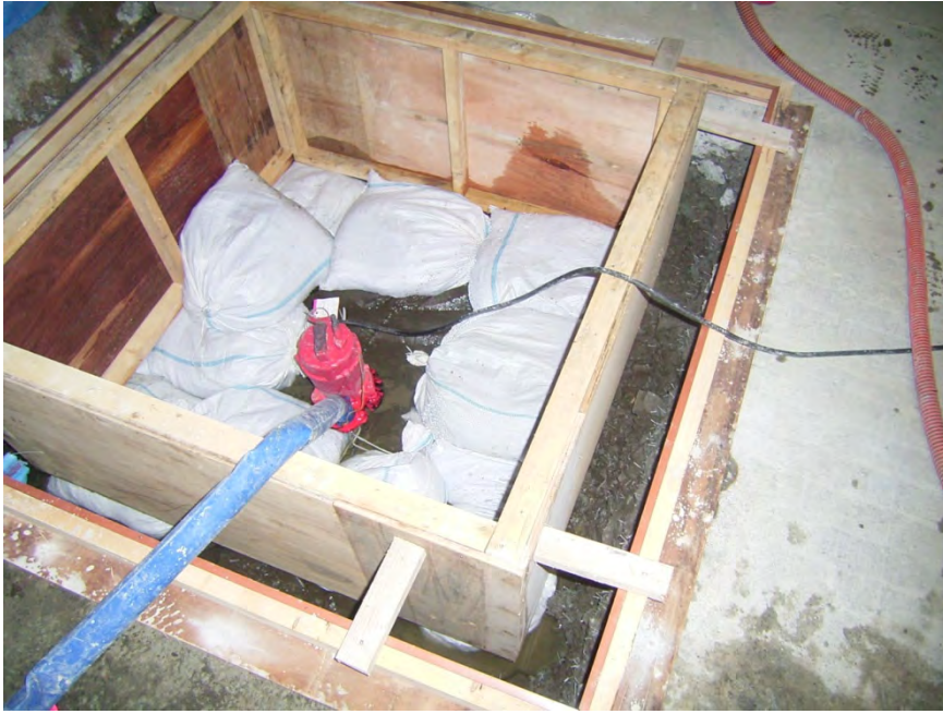
図 11.1.5-9 型枠設置完了
