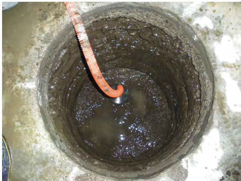
図 11.1.5-20 試験孔削孔完了
