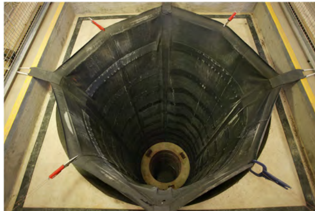
図 12.1.3-6 緩衝材ブロック設置時のゴムシート
