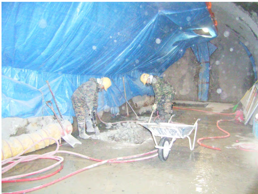
図 11.1.5-4 既設コンクリートハツリ状況（ブレイカー、ピックハンマー使用）
