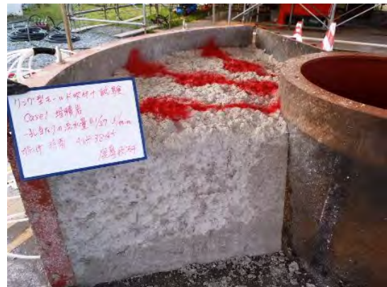
図 9.3.2-12 吹付け後の施工部 (Case1)
