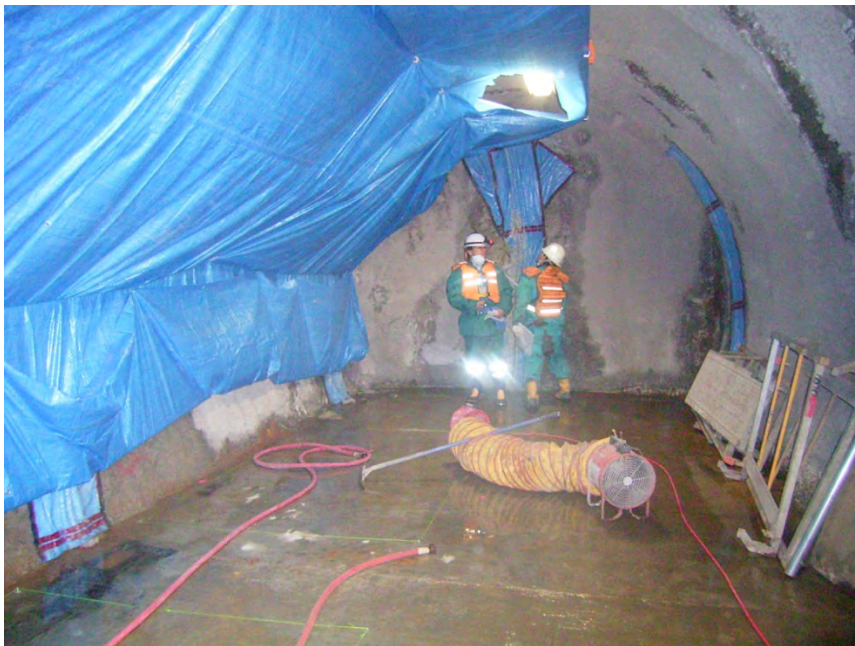
図 11.1.5-2 作業前現場養生状況
