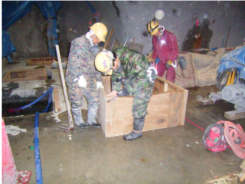
図 11.1.5-7 型枠作成状況
