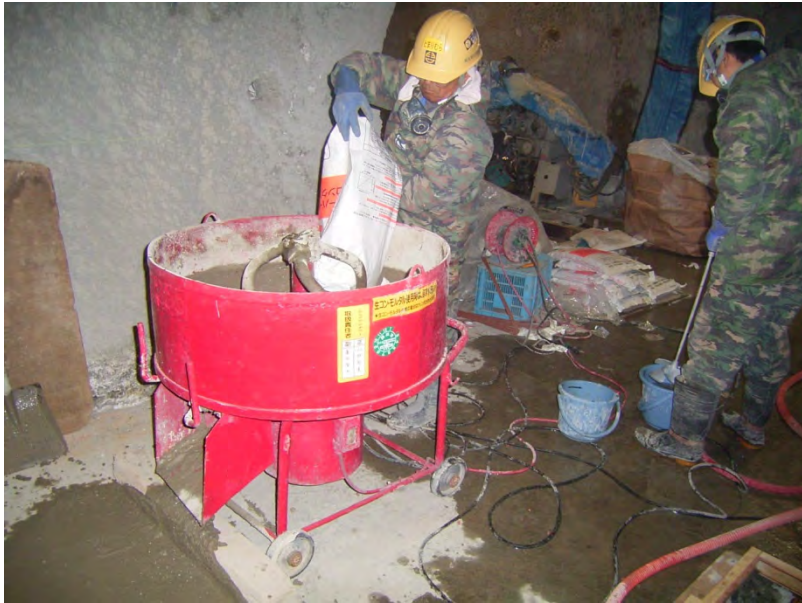
図 11.1.5-11 コンクリート打設② (材料練混ぜ)
