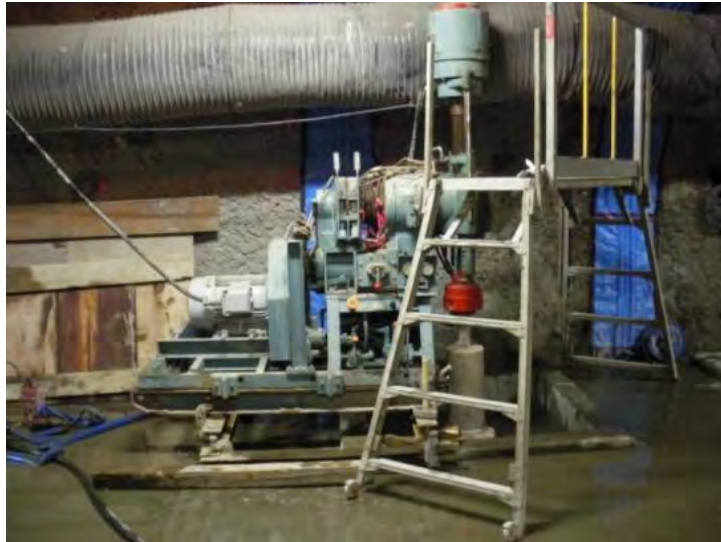
図 11.1.5-17 削孔状況（全景）
