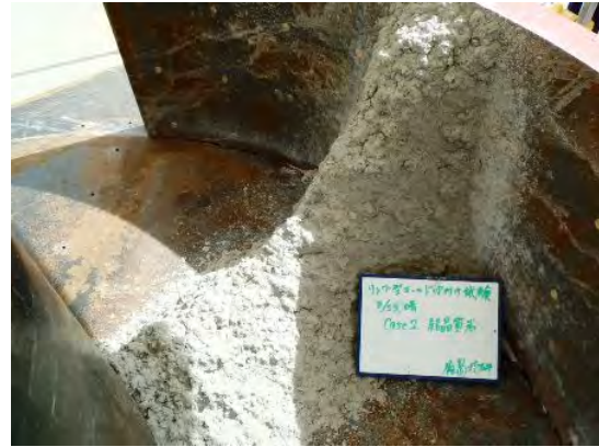
図 9.3.2-19 吹付け後の施工部 (Case2)
