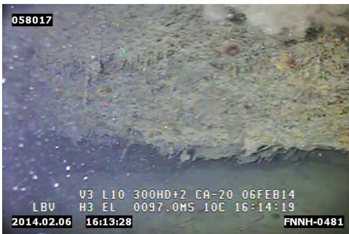
写真 5-2-23 海底湧水と推定された地点周辺の深さ 100m の海底の様子 -生物が張り付いている固結物-
