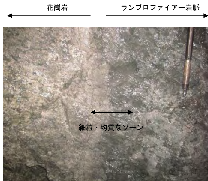
図 2.1-33 瑞浪超深地層研究所の主立坑壁面で認められるランプロファイアー岩脈と花崗岩の細粒・均質なゾーン（深度 218 m 付近）（窪島ほか, 2013 91) ）
