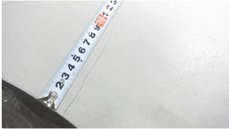
図 2.2-3 緩衝材（ID-100）のひび割れ（例）
