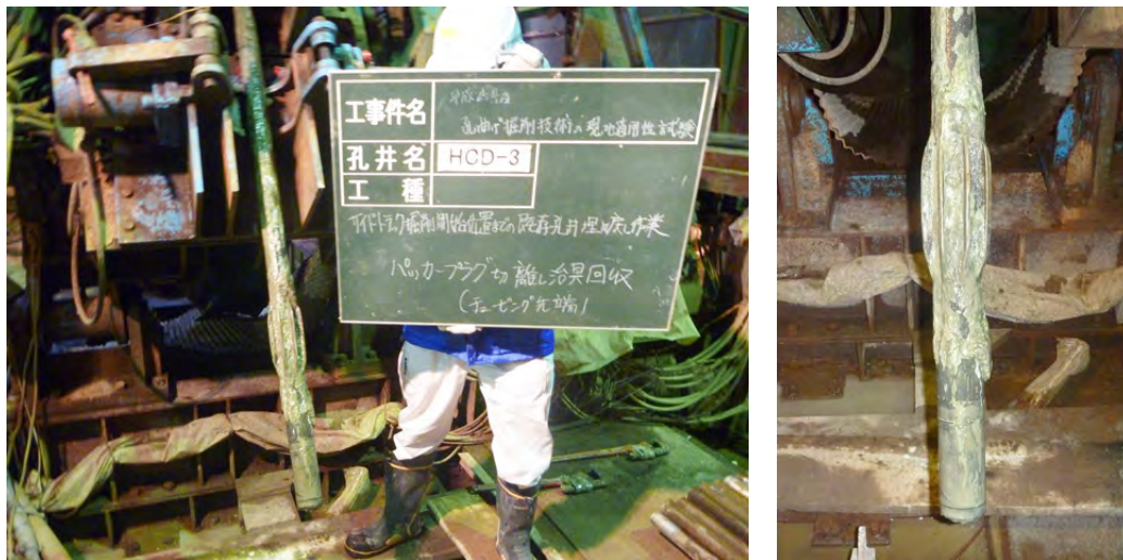
図 8.2.2-9 小口径ロッド(BQ ロッド)の揚管作業状況
