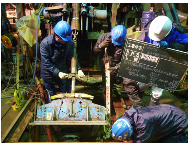
図 8.2.1-7 孔内閉塞用パッカープラグ設置位置の残尺検尺状況
