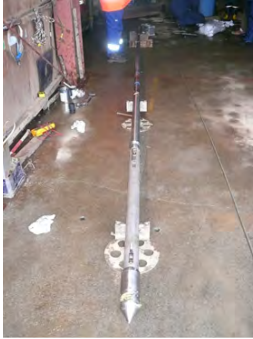
図 8.5.4-4 電動カッター組み立て状況(1回目)
