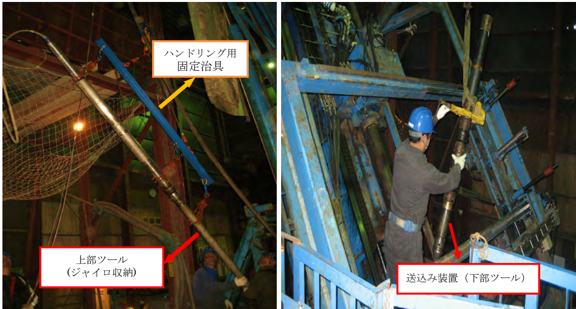
図 8. 2. 4-9 ジャイロシステムの計測準備作業状況
