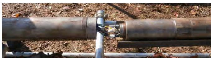
図 6. 2. 2-3 試験装置のケーブル連結状況
