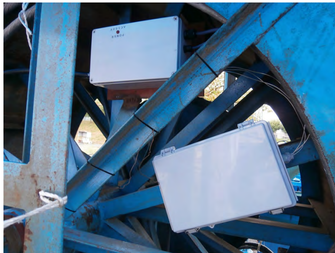
図 6.2.1-8 ケーブルウィンチ内光変換器ボックス(上)・光ファイバー中継ボックス(下)取付状況
