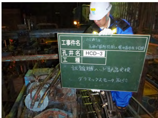
図 8.2.2-16 ダウマックスモータの取り付け状況
