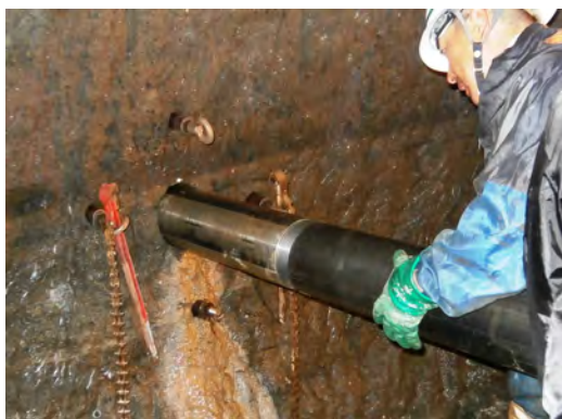
図8.4.2-1 165mm鋼管挿入状況
