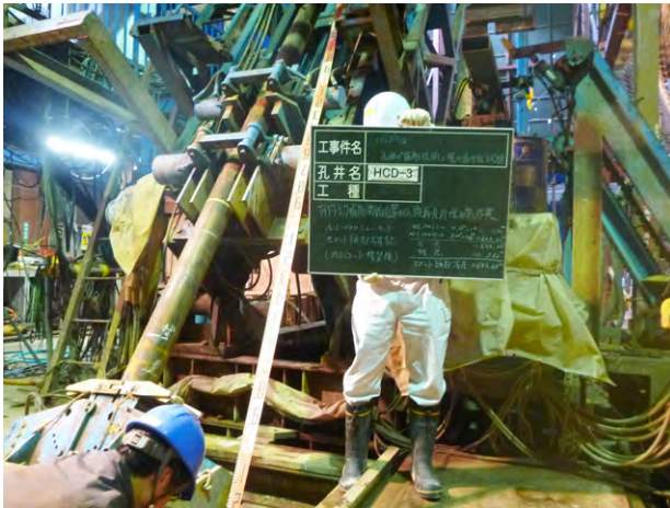
(NL140 ロッドガイド管による硬化セメント頂部位置検尺)
