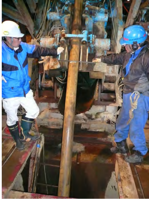
図 8.5.3-8 押し込み耐力試験状況
