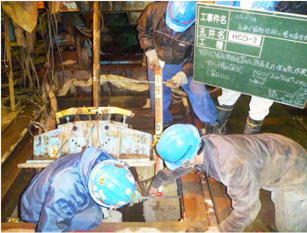
(BQ ロッド注入管による硬化セメント頂部位置検尺)
