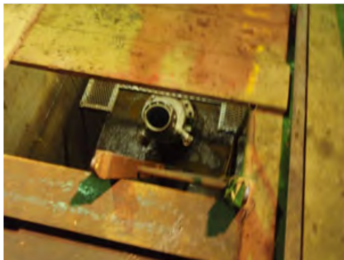
図 8.5.7-9 設置前孔井状況
