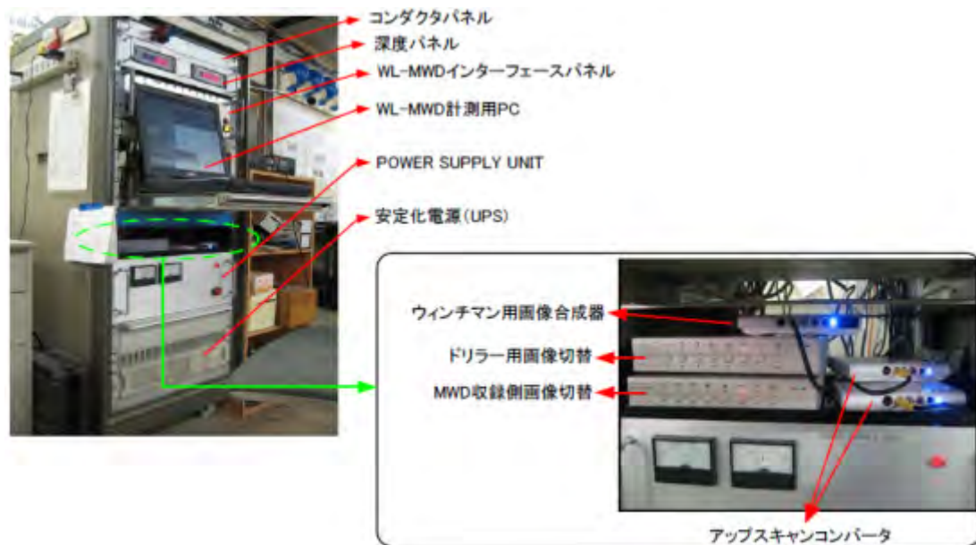
図 8. 2. 4-2 WL-MWD 計測用システムラック
