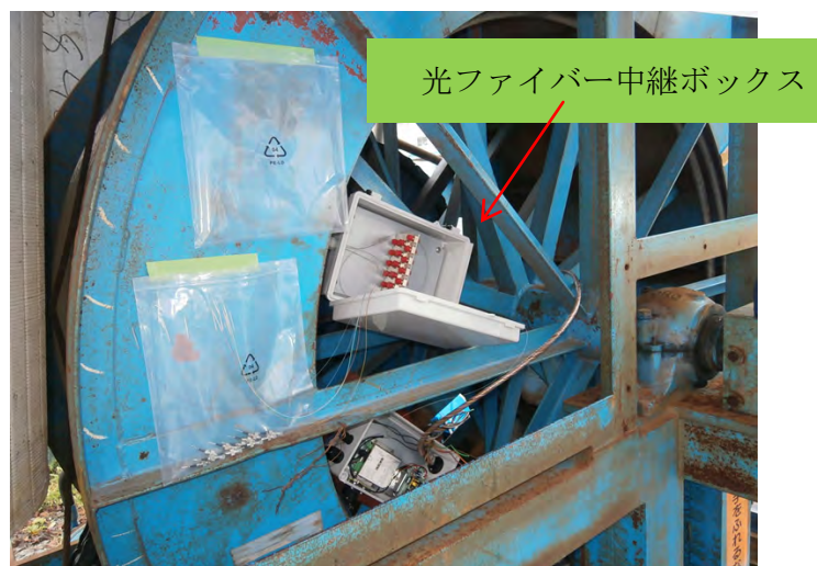
図 6.2.1-5 ウィンチドラムへの光ファイバー中継ボックス取付状況
