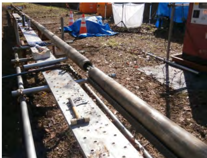
図 6. 2. 2-2 試験装置の架台上での組立状況
