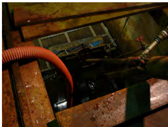
図 8.5.7-4 清水置換作業状況(2)
