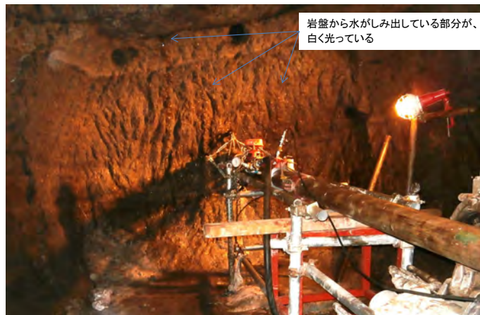
図 8.4.2-17 試験中の孔口周辺からの漏水状況
