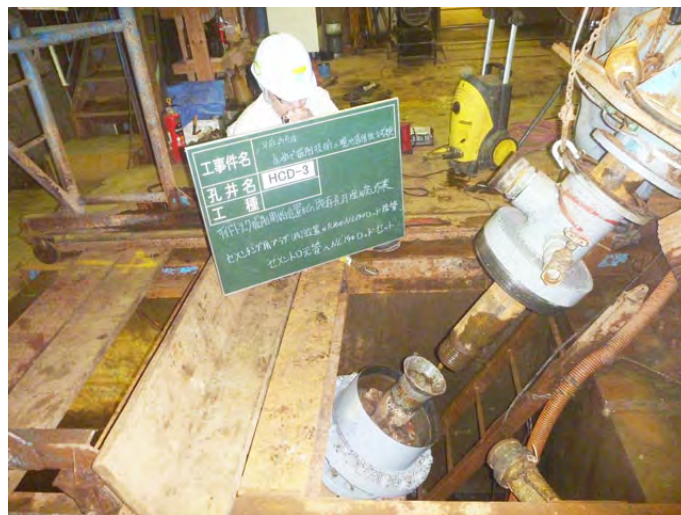
図 8.2.1-5 保護管(NL140 ロッド)の設置状況
