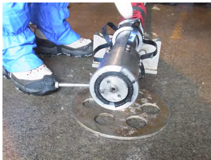
図 8.5.3-9 発破後の装薬治具状況
