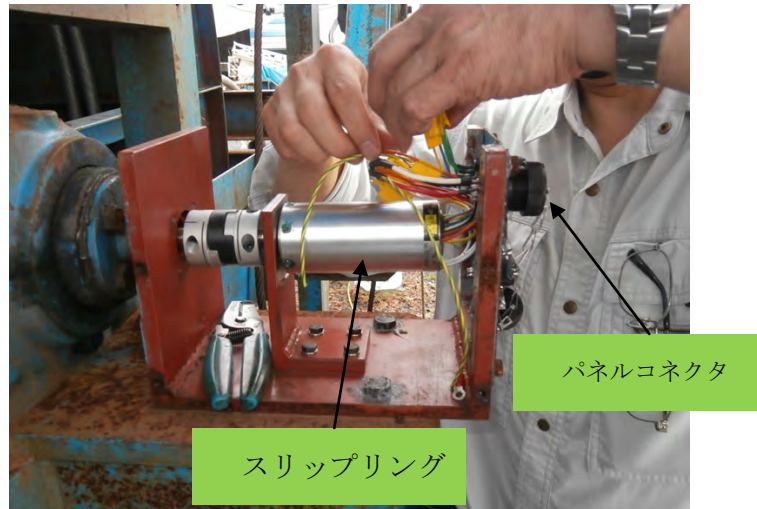
図 6.2.1-7 ウィンチドラムパネル配線作業状況
