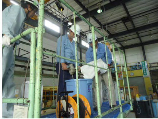
図 5.1.2-5 充填材の練混ぜ状況
