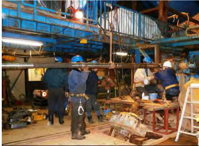
図 8.4.1-2 孔内応力試験装置の組立状況
