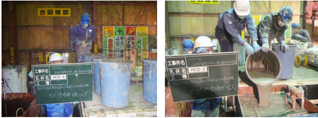
図 8.2.2-4 練上げ作業状況
