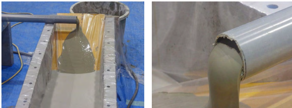
図 5.1.2-16 ベントナイト水溶液中への打設状況
