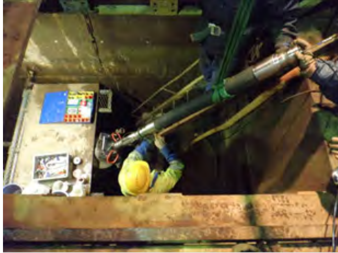
図 8.5.7-10 設置作業状況(1)
