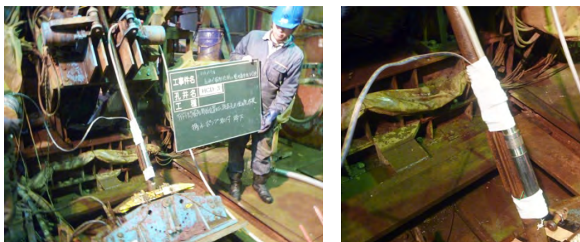
図 8.2.2-2 揚水ポンプ (MP-1) の取り付け降下作業
