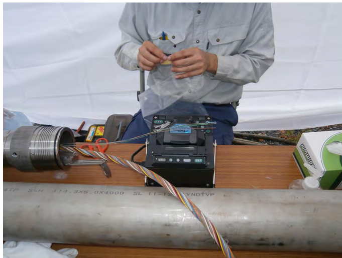
図 6.2.1-4 光ファイバーケーブルコネクタ取付のための融着作業状況
