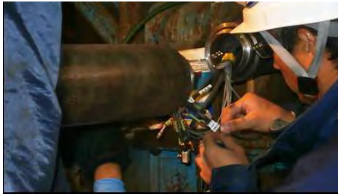
図 8.4.1-3 孔内応力試験装置の組立(ケーブル連結)状況
