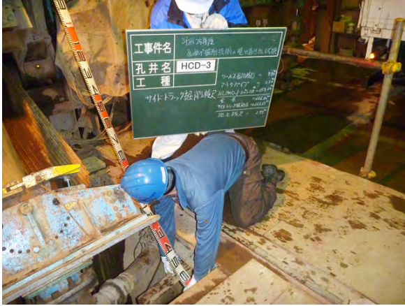
図 8.2.3-8 サイトラック掘削終了時検尺写真
