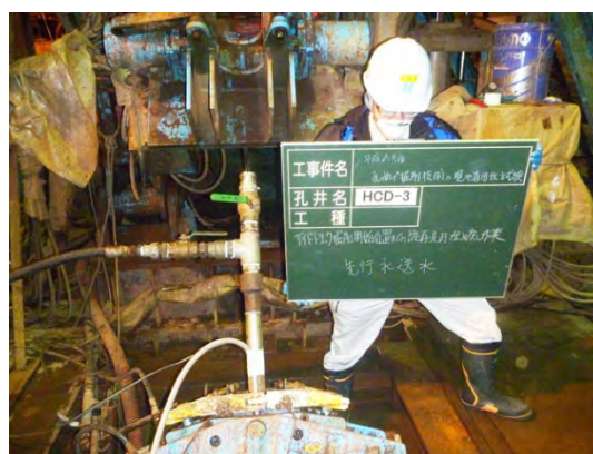
図 8.2.2-3 先行水の送水実施状況
