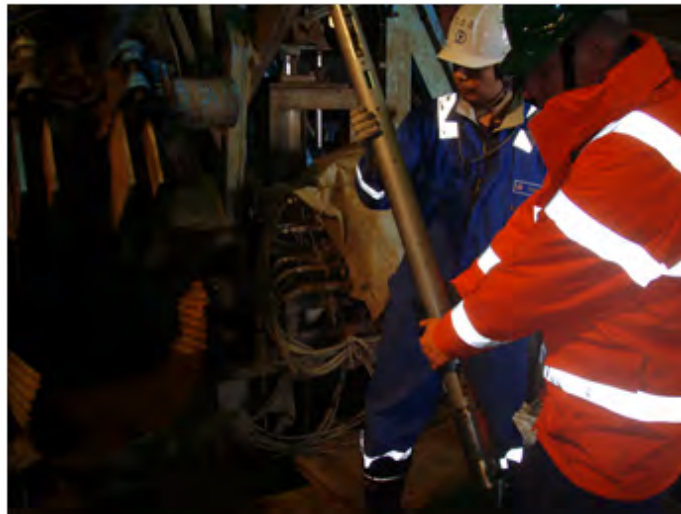
図 8.5.4-10 電動カッター設置状況(2回目)
