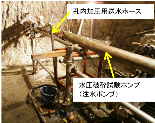
試験時の孔口状況
