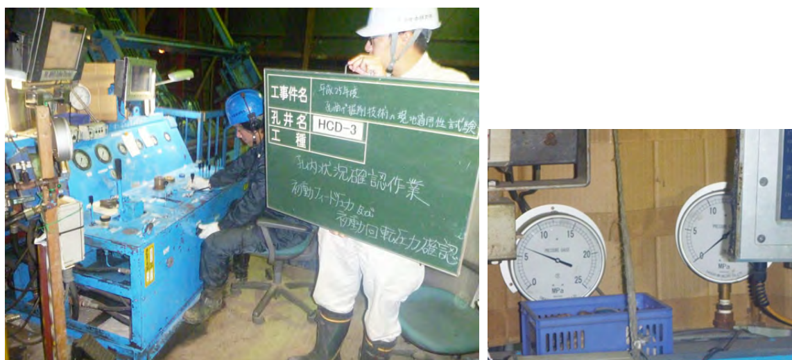
(左：初動圧力計測状況、右：ゲージによる圧力値確認)
