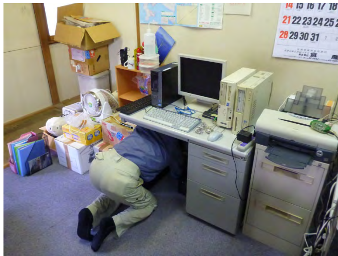
図 9.1.2-5 システムの設置作業状況
