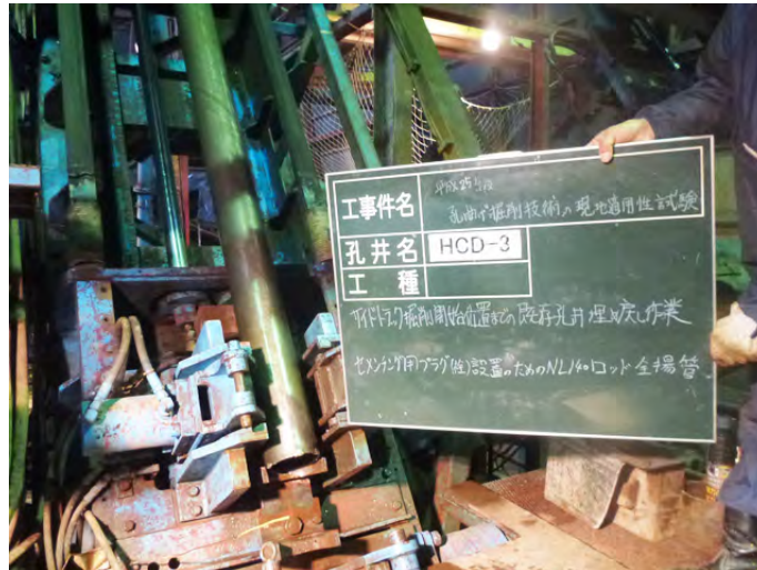
図 8.2.2-11 保護管(NL140 ロッド)の揚管作業状況
