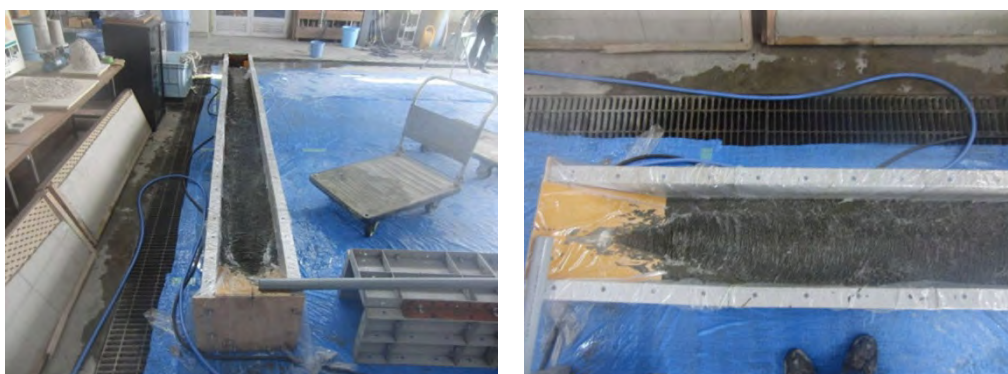
図 5.1.2-17 打設翌日のベントナイト水溶液接触面の状況
