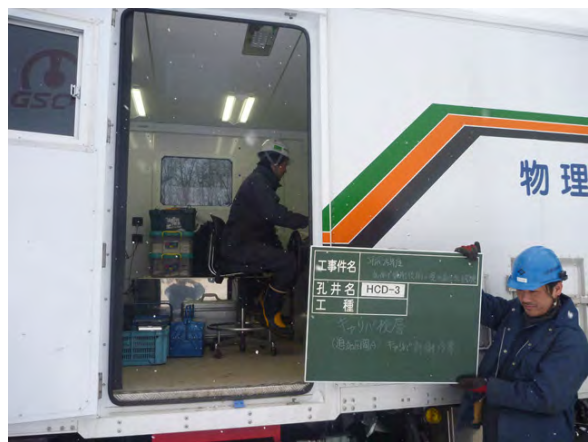
(追加区間 A 計測作業：ウインチ操作)
