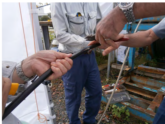
図 6.2.1-2 応力専用ケーブル被覆剥がし状況
