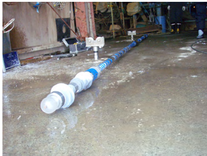
図 8.5.3-11 火工品組み立て状況
