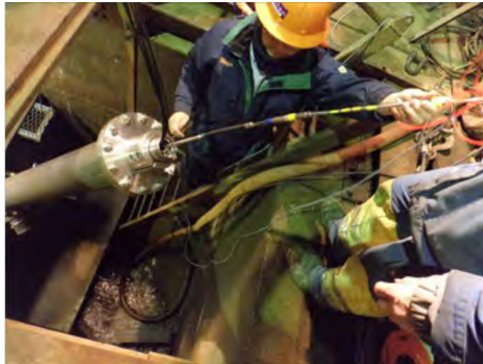
図 8.5.7-18 スタンドパイプ内圧力センサ設置作業
