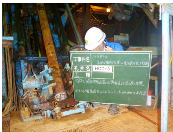
図 8.2.2-13 φ152mm コンポジットシュービット降下開始状況
