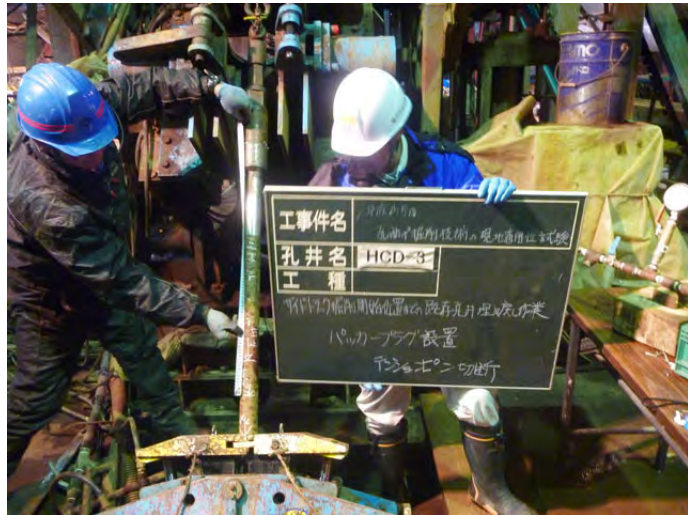
図 8.2.1-9 テンションピン切断後の同プラグ位置確認作業状況
