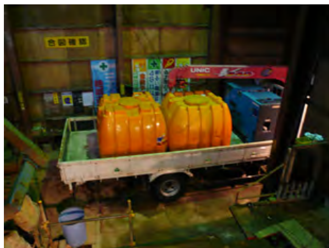
図 8.5.7-3 清水置換作業状況(1)
