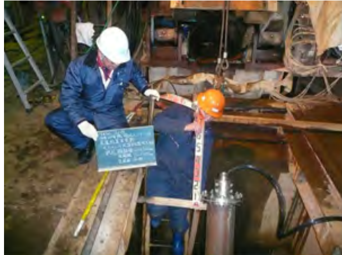
図 8.5.7-13 孔内モニタリングシステム設置完了
