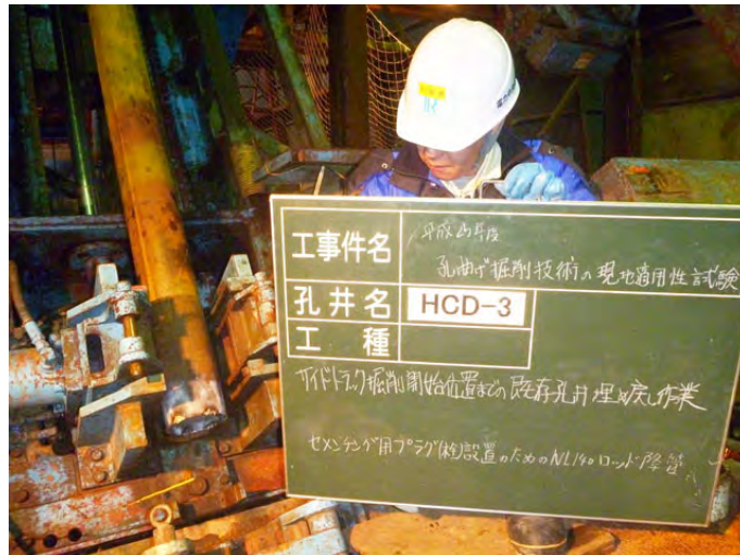
図 8.2.1-4 保護管(NL140 ロッド)の降管作業状況
