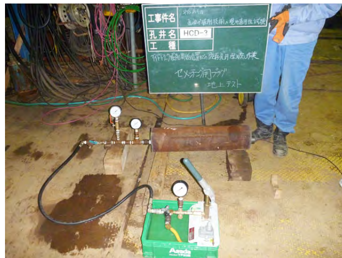
図 5.1.5-8 鋼管内における孔内閉塞用パッカプラグの拡張試験状況
