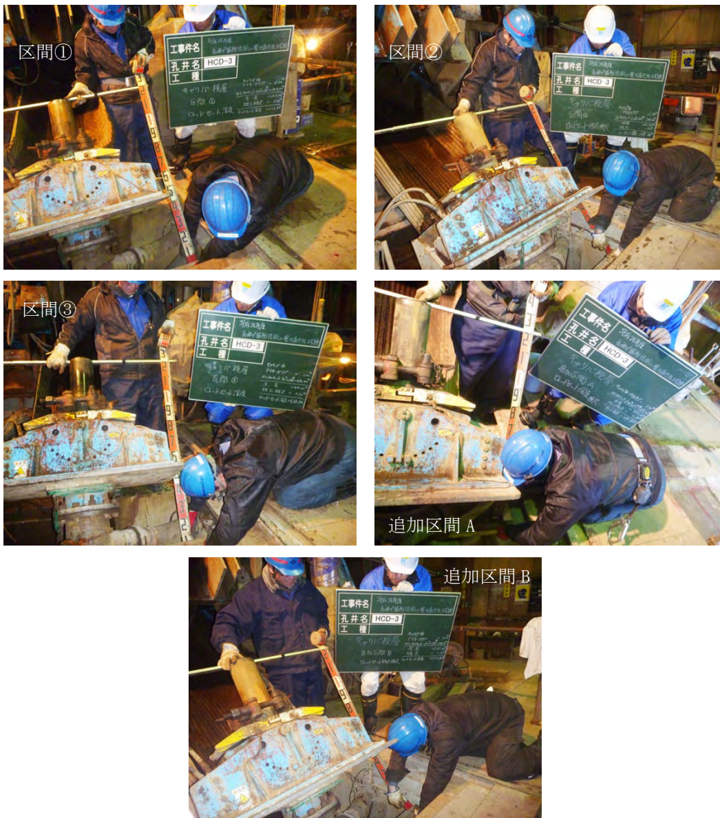
図 8.1.2-4 キャリパ計測区間毎のガイド管挿入残尺検尺
