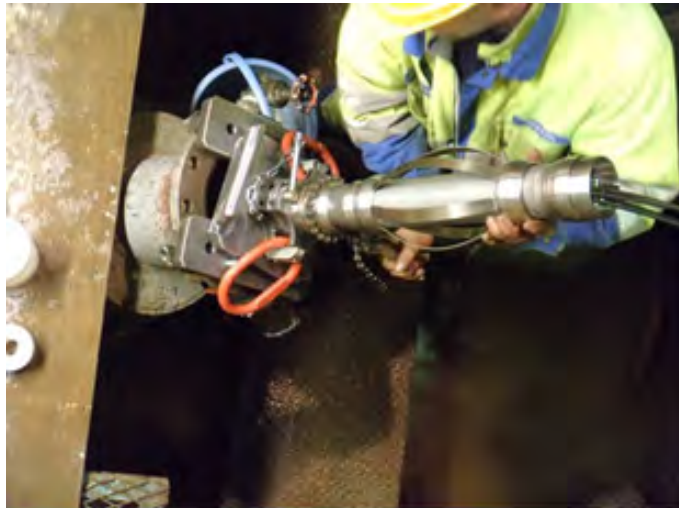
図 8.5.7-11 設置作業状況(2)
