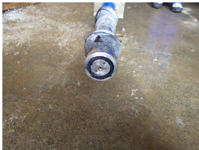
図 8.5.3-13 発破後の装薬治具状況
