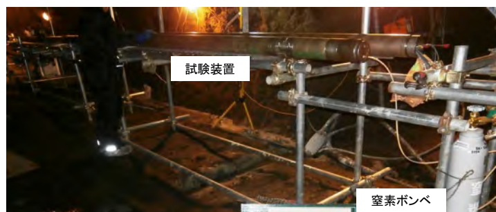
図 8.4.1-17 止水機能検証試験実施状況
