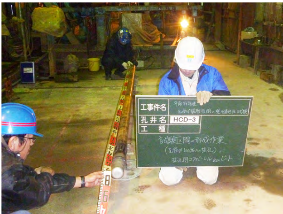
図 8.2.5-4 φ100mm 拡孔ビット装着時のコアチューブ
