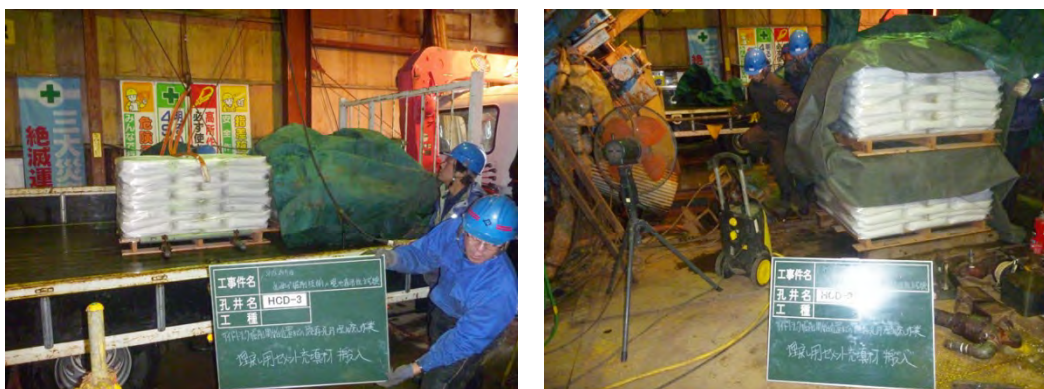
図 8.2.2-1 プレミックス材の搬入状況
