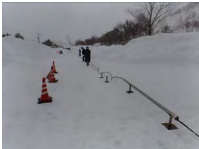
図 8.5.7-12 設置作業状況(3)
