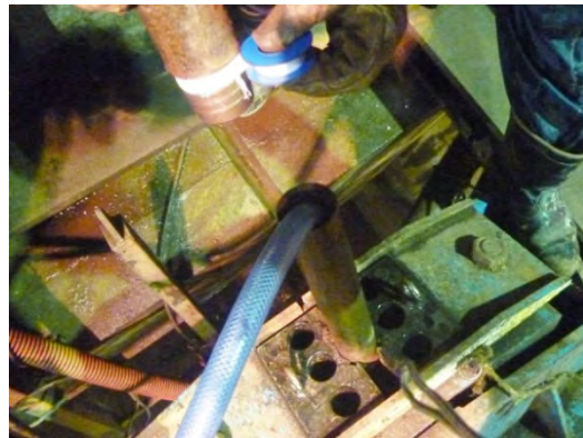
(左：ロッド接続降管作業、右：管内への補水状況)
