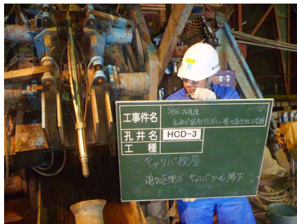
(追加区間 B 計測作業：キャリパツール降下開始)
