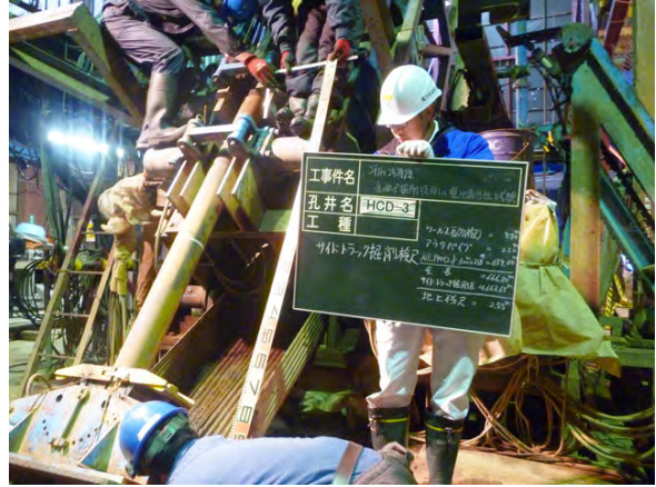
図 8.2.3-8 サイトラック掘削終了時検尺写真
