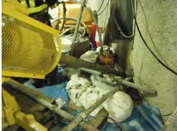
図 7.2.3-14 \phi 86\text{mm} (1 段目) 掘削状況
