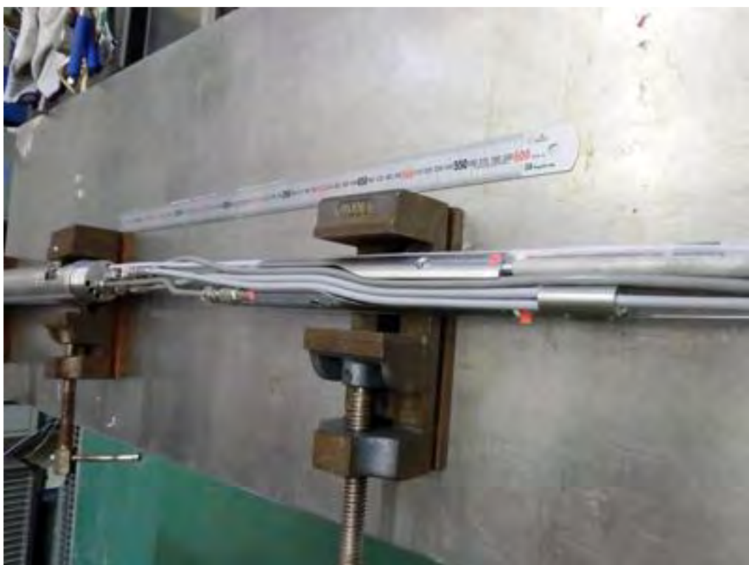
図 2.2.4-4 孔内装置部への循環バルブ組込み作業 2
