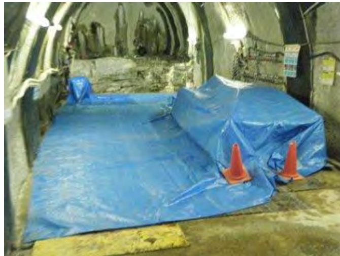
図 7.2.3-5 シート養生状況
