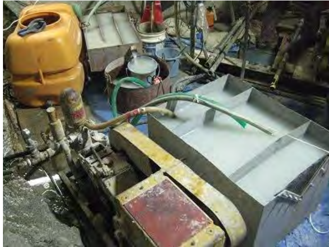
図 7.2.3-7 掘削水用タンク
