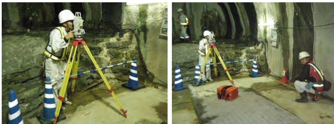
図 7.2.3-11 ボーリング位置の位置出し測量状況
