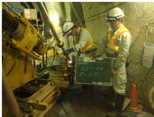
図 7.2.3-30 測定プローブ（BTV・フローメーター）の挿入状況
