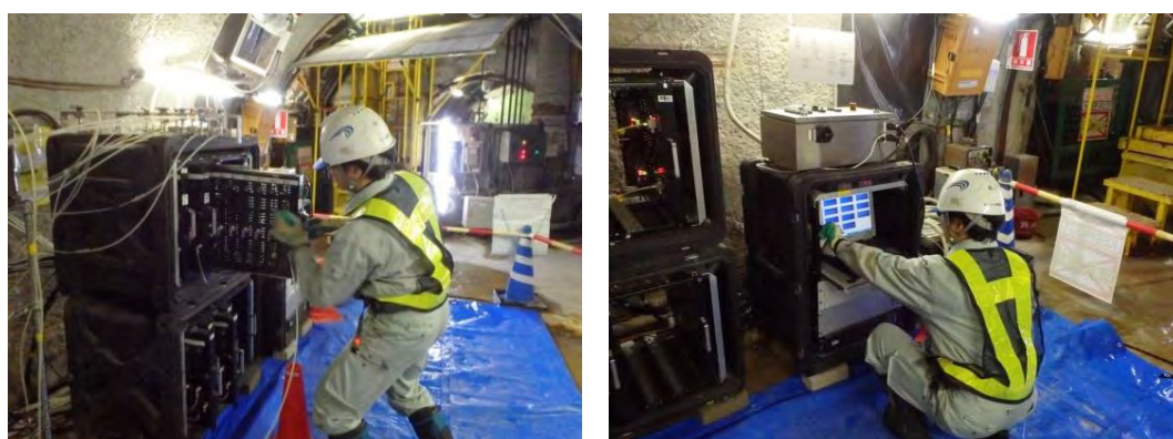
図 7.2.3-44 間隙水圧モニタリング装置（記録装置部）
