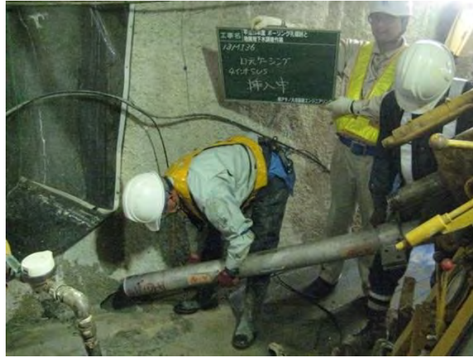
図 7.2.3-15 孔口ケーシング挿入状況
