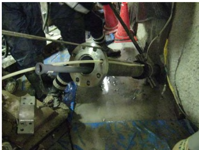
図 7.2.3-16 ケーシング設置状況
