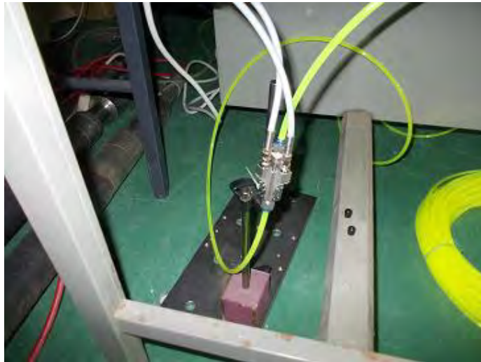
図 2.4.4-7 蛍光センサー1 の設置状況
