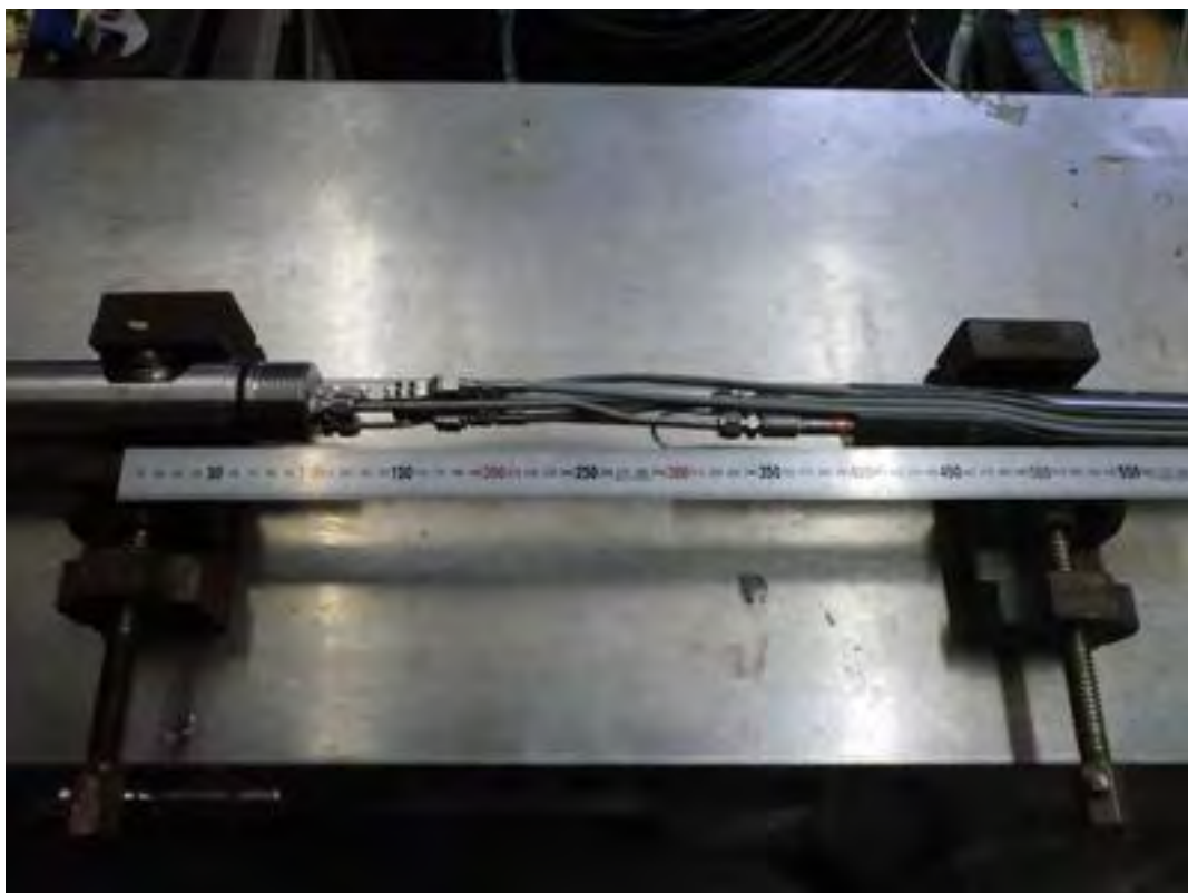
図 2.2.4-3 孔内装置部への循環バルブ組込み作業 1
