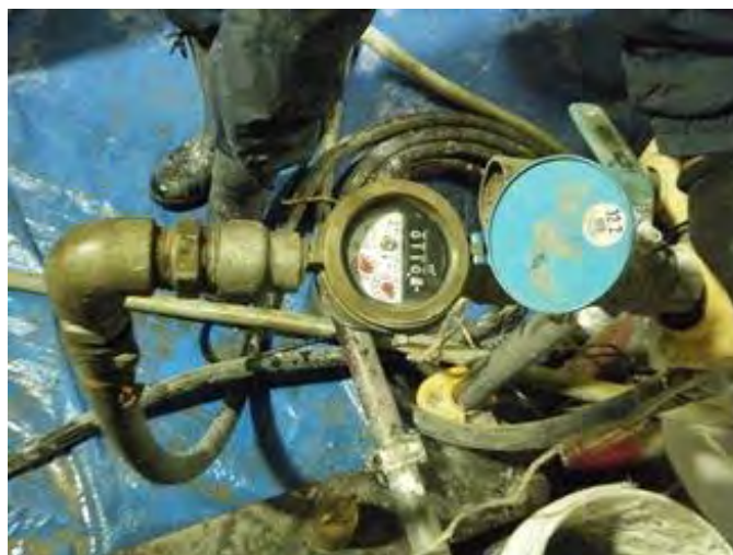
図 7.2.3-6 掘削水量の計測状況
