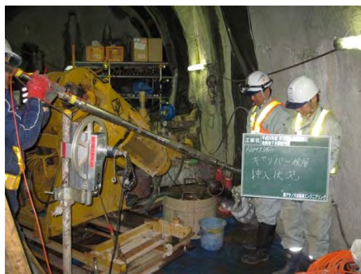
図 7.2.3-27 キャリパー検層ツール挿入状況
