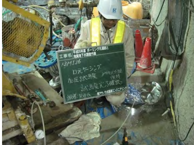
図 7.2.3-17 加圧試験状況
