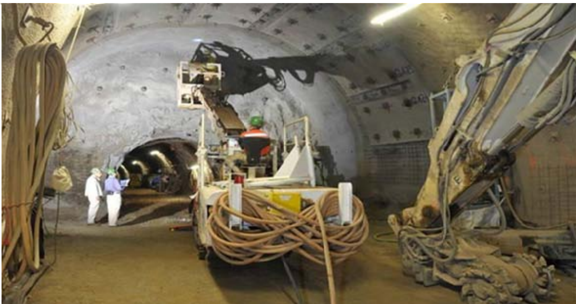
図 8.2-5 立坑ステーションの建設(コンラッド 2)(BfS)
