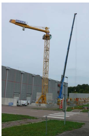
図 3.1-4 CSA のロット 9 作業の写真
