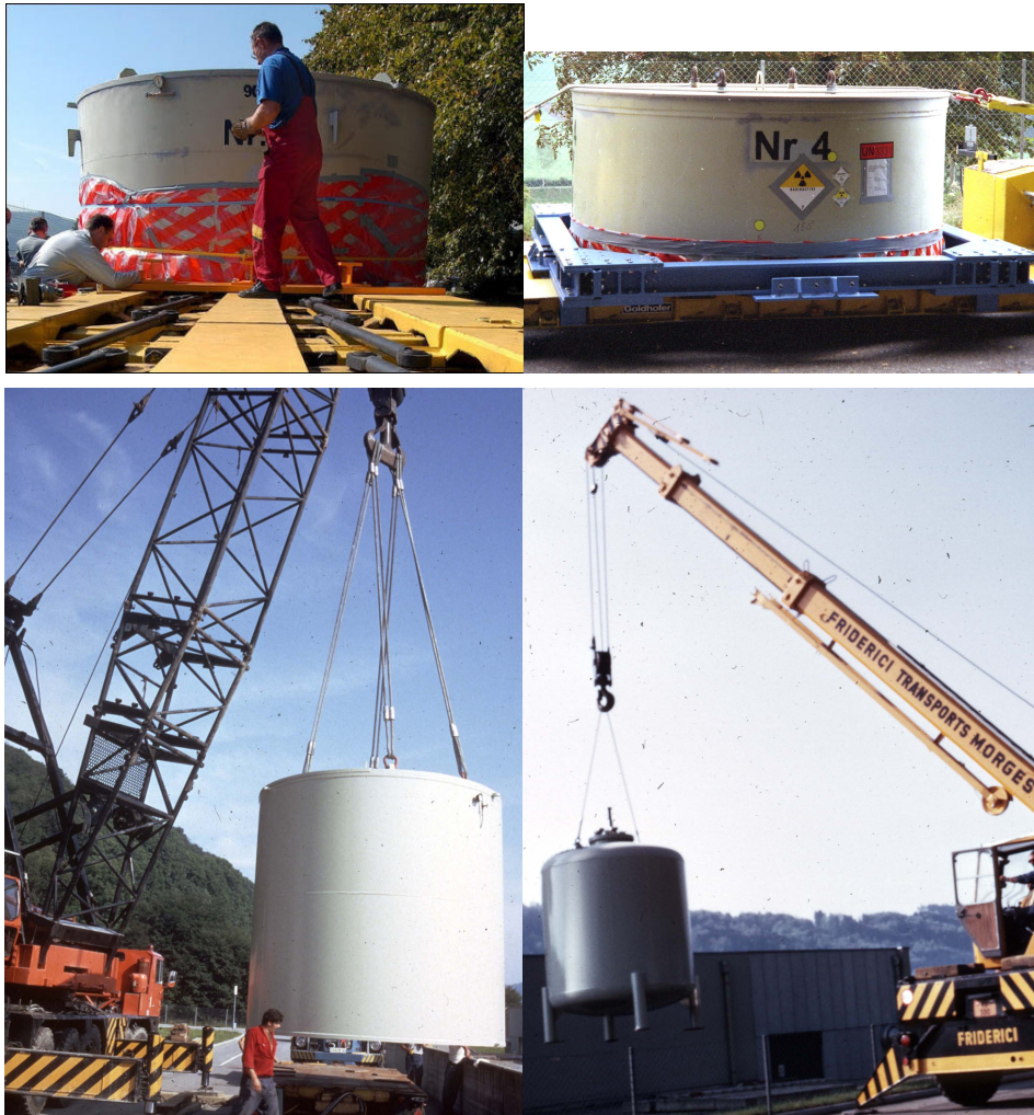
図 4.10-1 解体された原子炉から発生した放射性廃棄物を収容した 6 基の大型容器を、ルーセンから ZZL へ移送する写真(2003 年 9 月)
