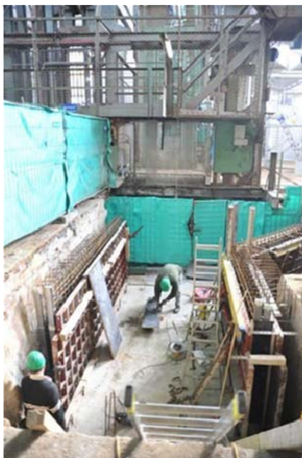
図 8.2-6 コンラッド 1 用立坑ホールの建設
