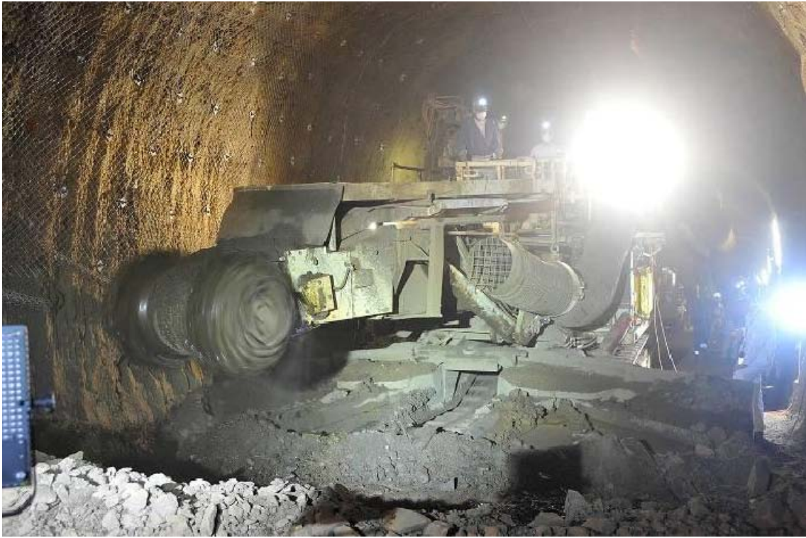
図 8.2-3 定置チェンバーの掘削(BfS)
