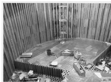
図 3.1-14 建築中黒鉛スタック
