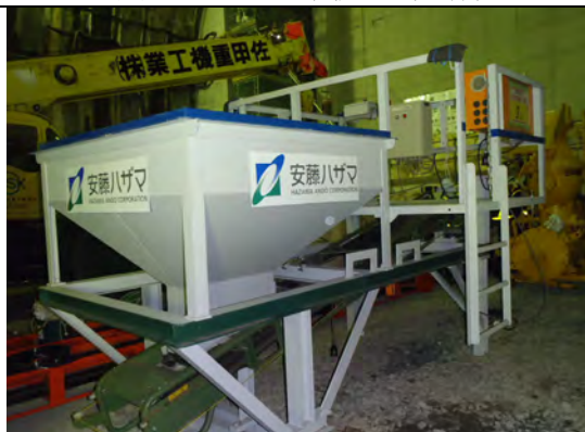
写真 1.3-18 使用機材（材料供給機）
