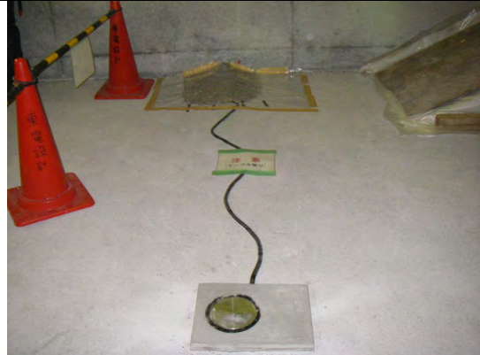
写真 1.4-4 計測計器設置状況
