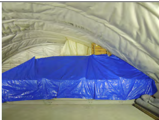
写真 1.3-77 上部緩衝材、埋戻し材養生(3)
