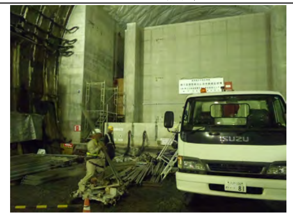
写真 1.1-4 昇降設備設置(1)
