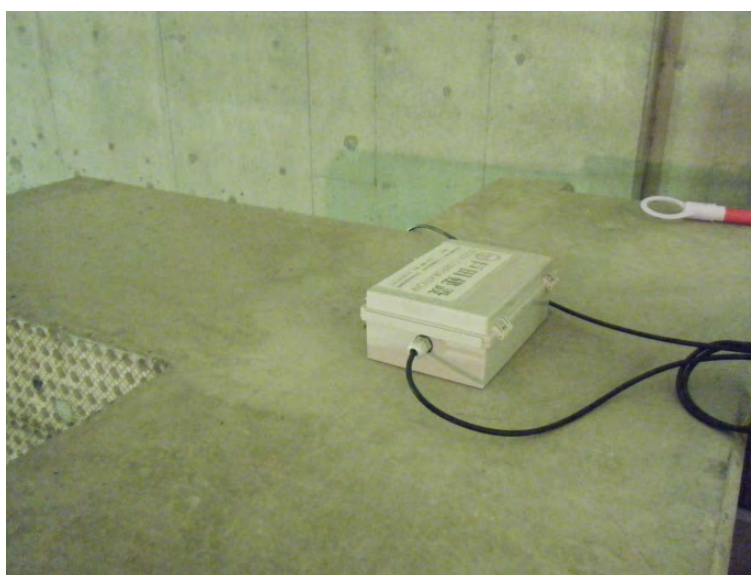
図 10.2-2 地震計設置状況写真 (地震計③)
