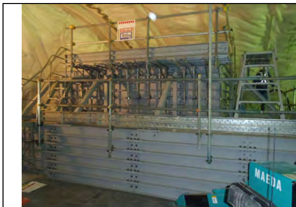
写真 1.3-16 足場仮設（全体）
