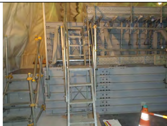
写真 1.3-17 足場仮設（昇降設備）
