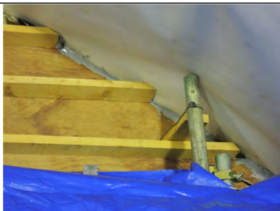
写真 1.3-76 上部緩衝材、埋戻し材養生(2)
