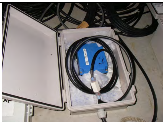
写真 1.4-13 地震計（ケース内部）
