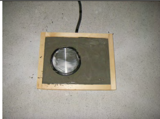
写真 1.4-2 計測計器養生
