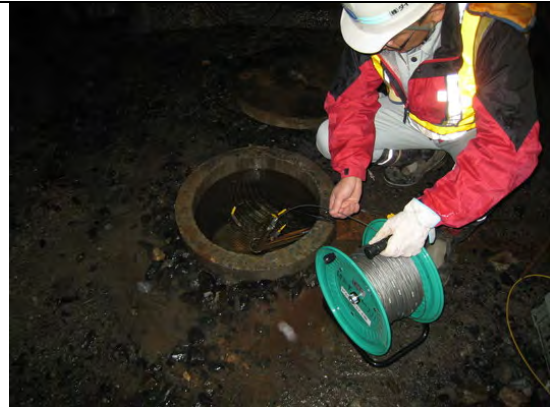
写真 1.4-18 計測状況 (B-1 孔)
