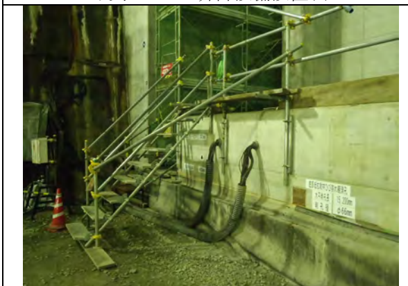
写真 1.1-7 昇降設備設置(4)
