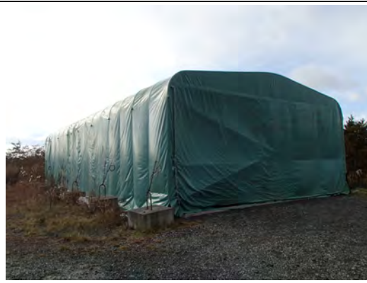
写真 1.1-54 ベントナイト保管庫復旧完了
