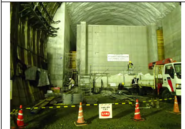
写真 1.1-5 昇降設備設置(2)
