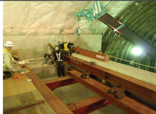
写真 1.1-14 転落防止柵設置(1)
