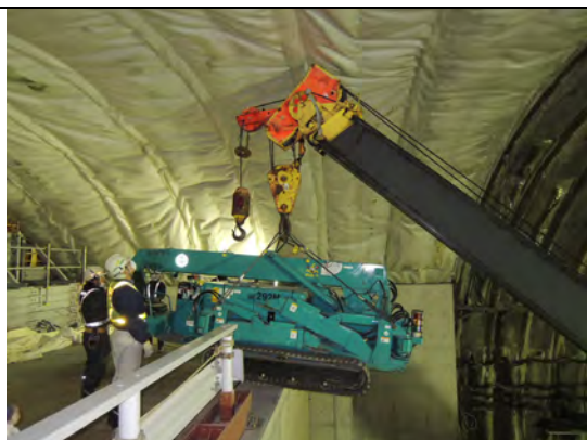
写真 1.3-73 小型クレーン撤去状況(2)
