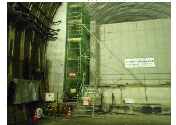
写真 1.1-8 足場組立完了
