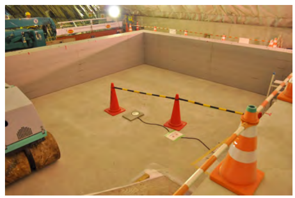
写真 1.2-24 型枠組立完了 (内部)
