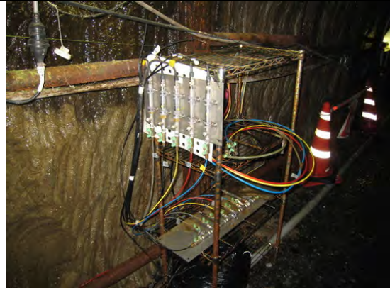
写真 1.4-20 間隙水圧計回収前状況
