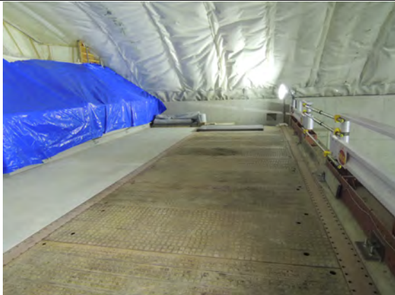
写真 1.3-78 上部緩衝材、埋戻し材養生(4)
