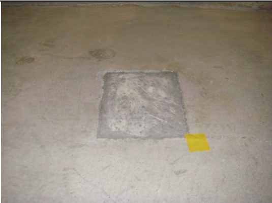
写真 1.4-7 ジョイント部養生
