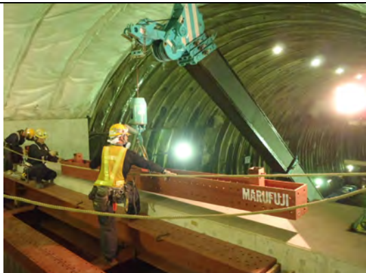
写真 1.1-15 転落防止柵設置(2)
