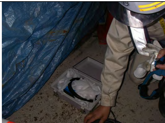
写真 1.4-15 地震計メンテナンス状況
