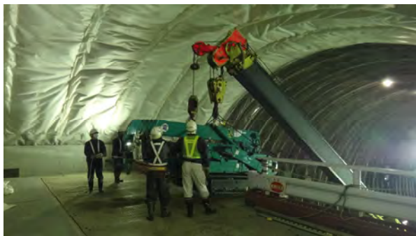
写真 1.3-72 小型クレーン撤去状況(1)
