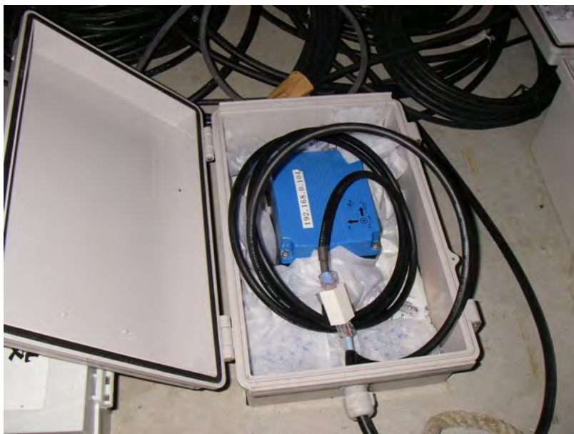
図 10.2-3 地震計設置状況写真（養生ケース内）
