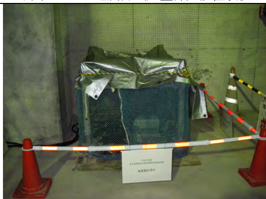
写真 1.4-11 地震計（底部ピット部）保護養生
