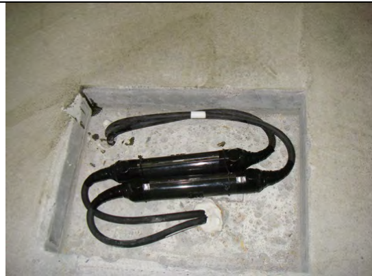
写真 1.4-6 ケーブルジョイント
