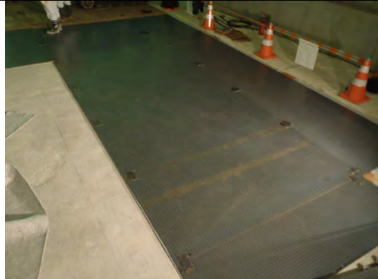
写真 1.2-18 上部低拡散材養生縞鋼板敷設(2)
