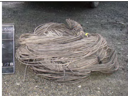
写真 1.4-35 撤去した先行ケーブル (174 本)
