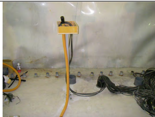
写真 1.4-33 上部緩衝材計器用箱抜き
