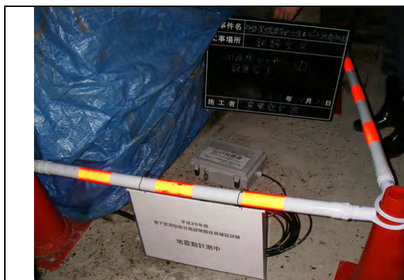
写真 1.4-9 地震計（底盤部）設置状況
