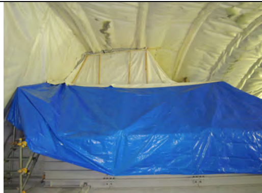
写真 1.3-75 上部緩衝材、埋戻し材養生(1)
