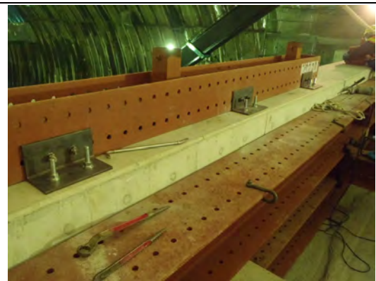
写真 1.1-16 転落防止柵設置(3)
