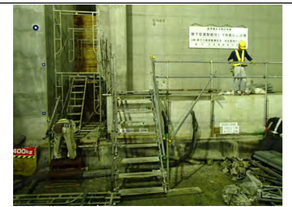
写真 1.1-6 昇降設備設置(3)
