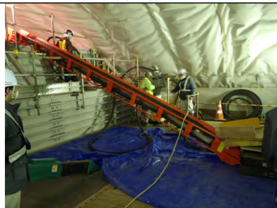
写真 1.3-23 撤出し材料供給用ベルトコンベア
