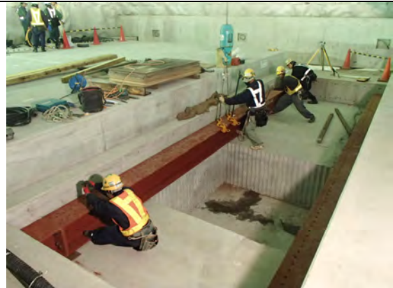
写真 1.1-12 開口部養生 施工状況(1)
