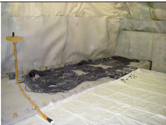
写真 1.4-34 先行ケーブルの整理後
