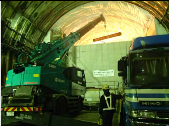
写真 1.1-11 開口部養生 資材搬入(3)
