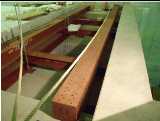
写真 1.1-13 開口部養生 施工状況(2)
