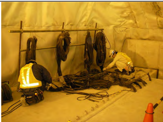
写真 1.4-32 先行ケーブルの整理状況
