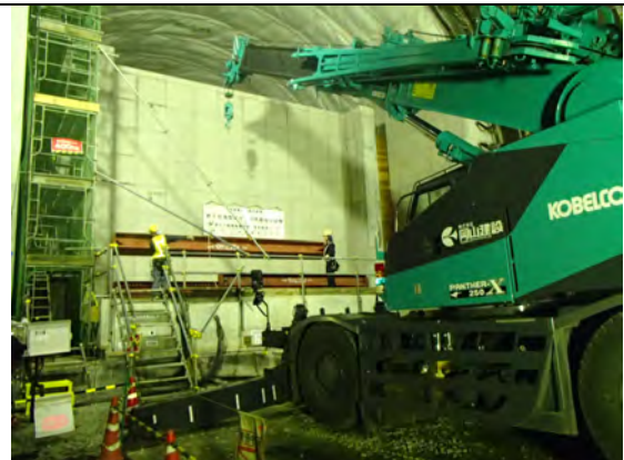
写真 1.1-10 開口部養生 資材搬入(2)
