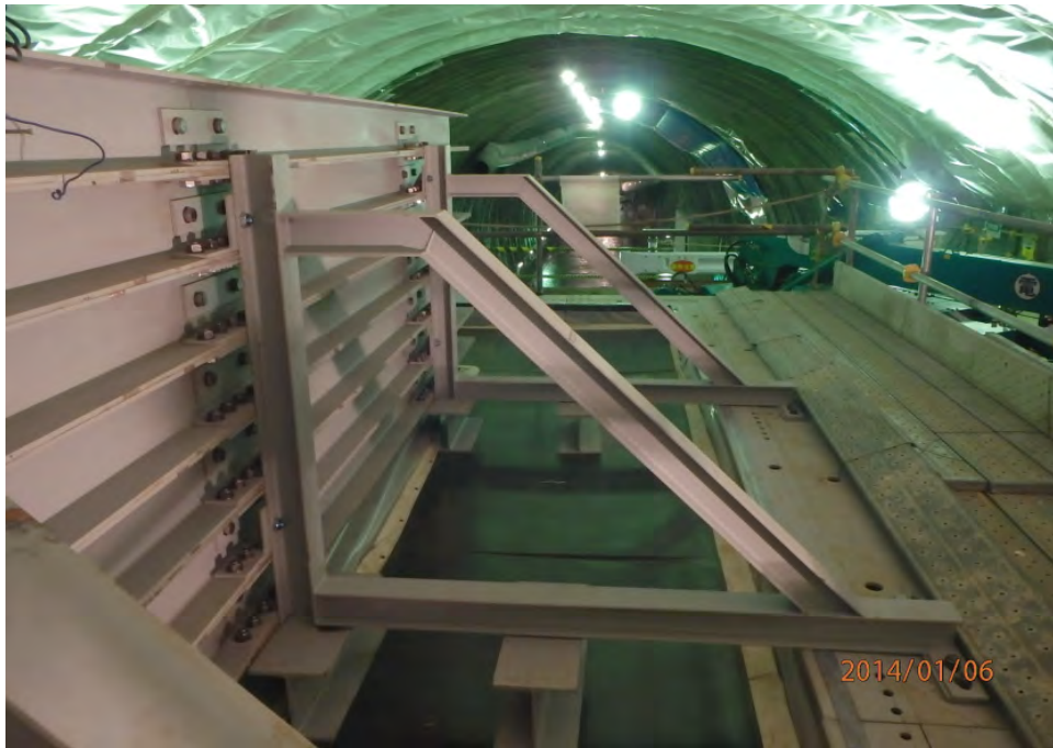
図 5.1-23 抑え金物設置状況
