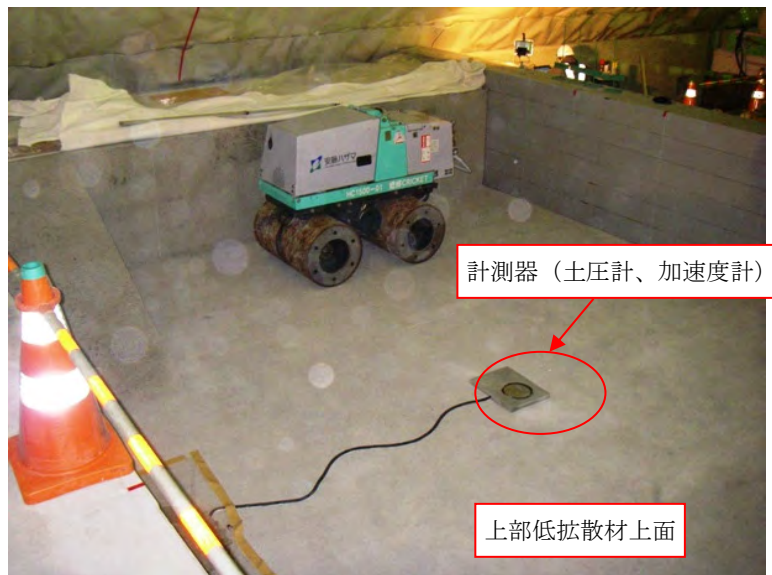
図 8.2-3 計器設置後状況写真
