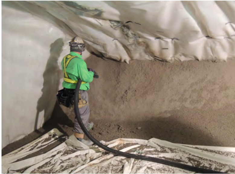
図 5.1-30 人力吹付け状況
