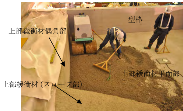
人力による敷均し状況
