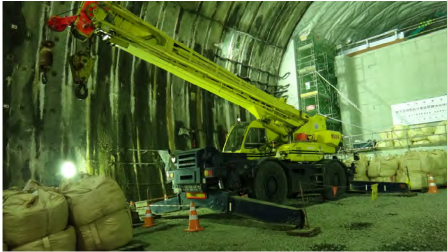
図 5.1-13 25 t ラフタークレーン
