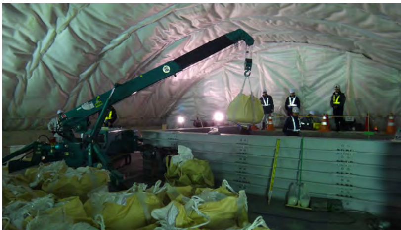
図 3.1-33 ベントナイト（フレコン）の供給状況
