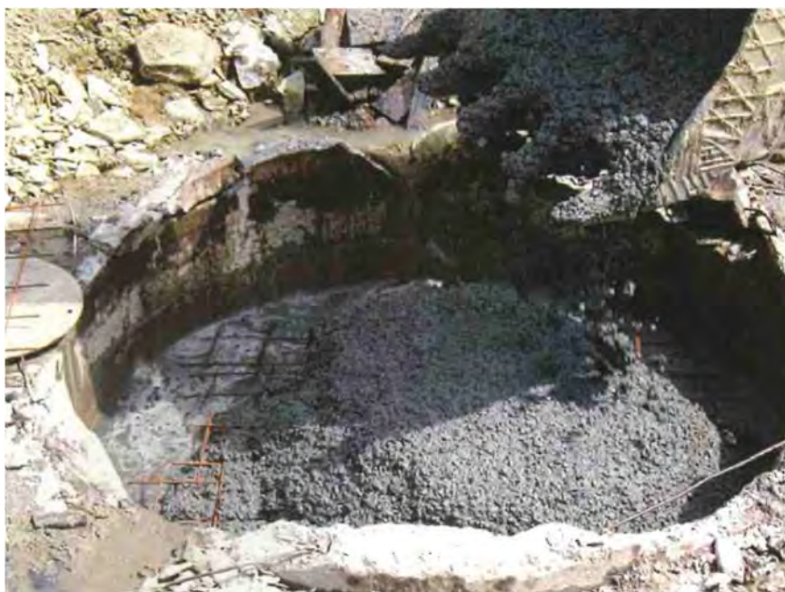
図 9.2-18 コンクリートキャップ打設[12]
