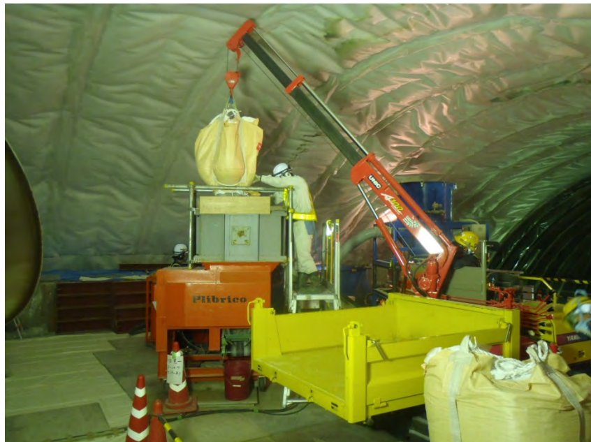
図 2.1-18 フレコンからの材料投入状況（2t キャリアダンプ使用）
