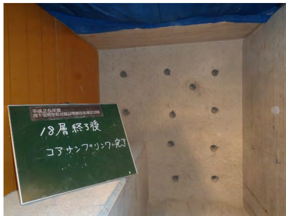
図 2.2-5 ハンディコアドリルでの試料採取位置（18層目）
