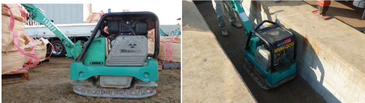
図 4.2-6 バイブロコンパクトによる施工状況
