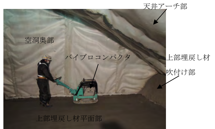
バイブロコンパクタによる転圧状況
