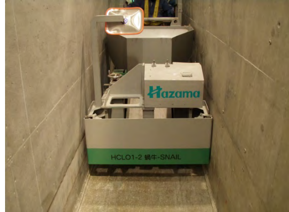
図 3.1-5 敷均し機による側部敷均し
