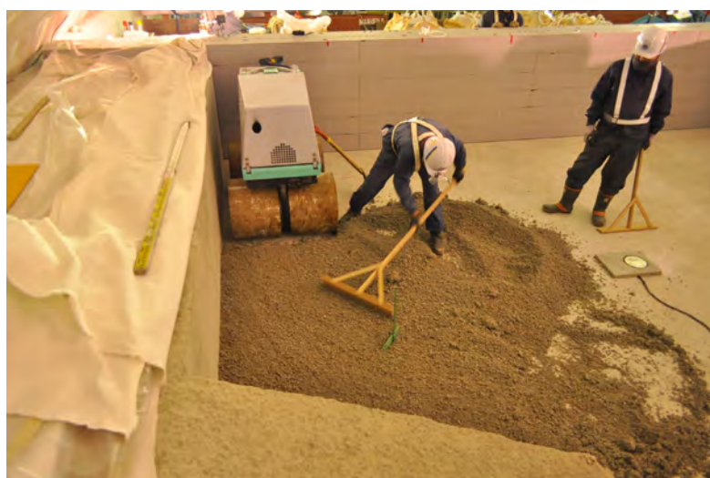
図 3.1-38 ベントナイト敷均し状況
