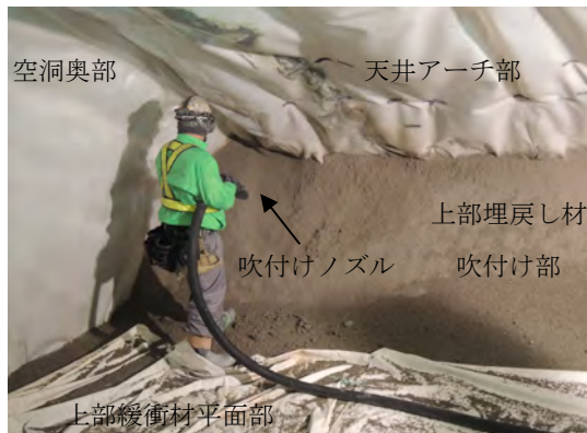
人力吹付け状況
