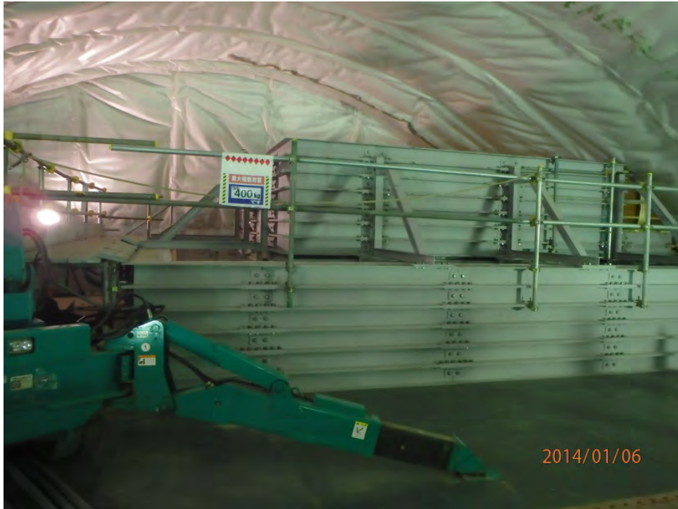
図 5.1-22 上部埋戻し材型枠設置状況
