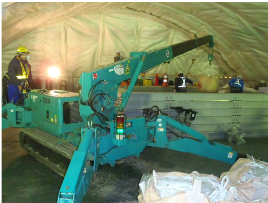
図 3.1-22 カニクレーン (2.98 t 吊)
