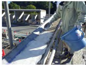
ベントナイト敷均し
