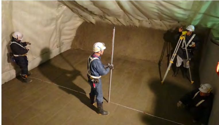
図 5.1-53 レベル測量の状況
