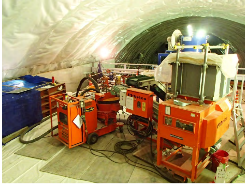
図 2.1-11 吹付け機材のレイアウト
