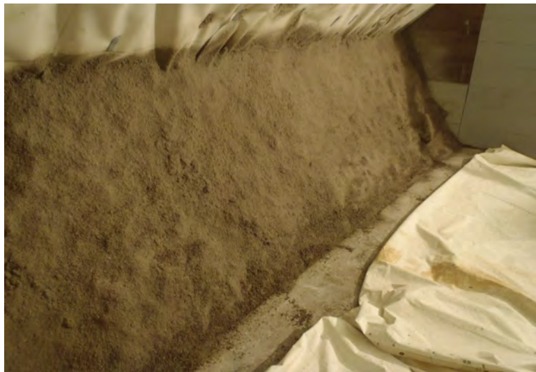
図 5.1-31 吹付け後状況
