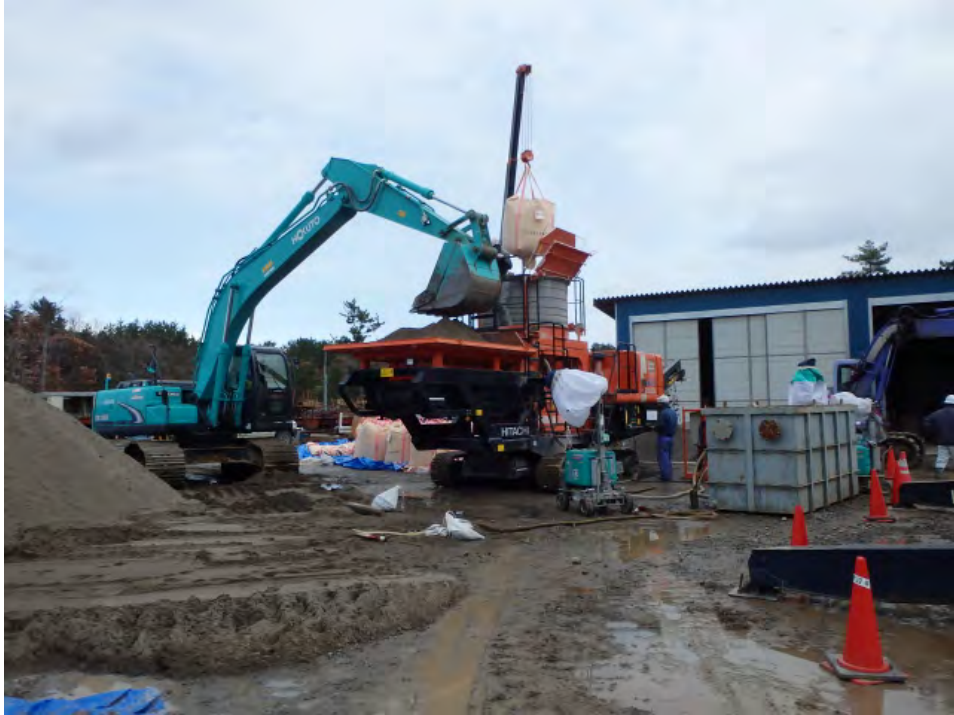
図 5.1-16 ベントナイト混合土製造状況
