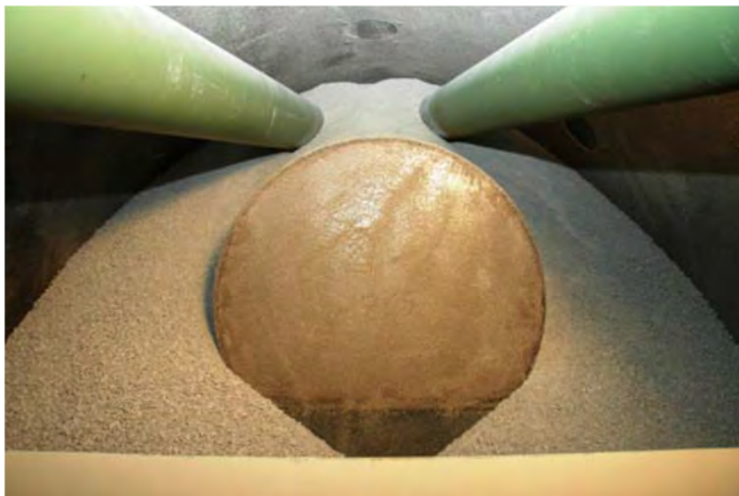
図 9.2-7 緩衝材構築技術に關する検討例 (ベントナイトペレットの充填状況) [6]
