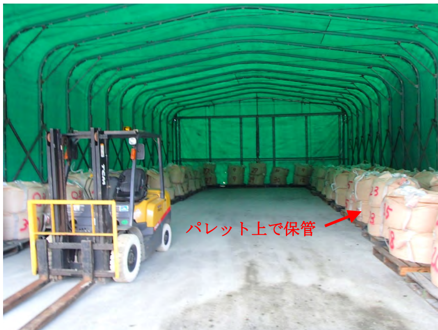
図 2.1-14 ベントナイト保管庫の仮置き状況
