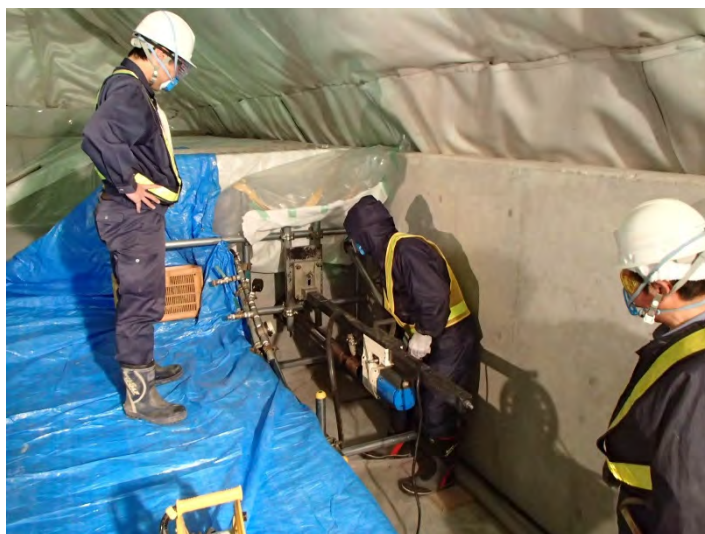
図 2.2-2 長尺ボーリングマシンによるコア抜き状況
