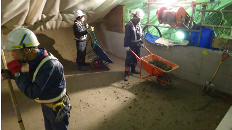
図 5.1-41 材料の運搬状況
