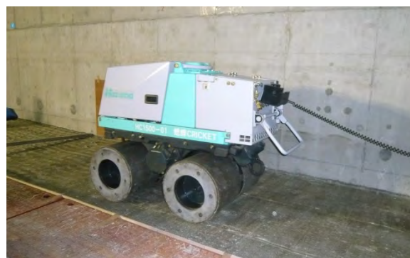
図 3.1-3 小型振動ローラによる施工状況
