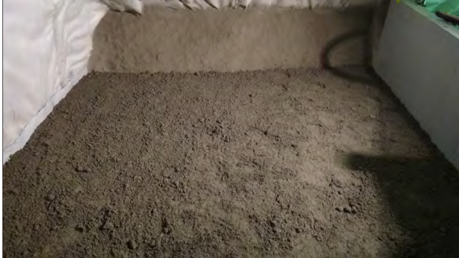
図 5.1-46 敷均し完了後の状況
