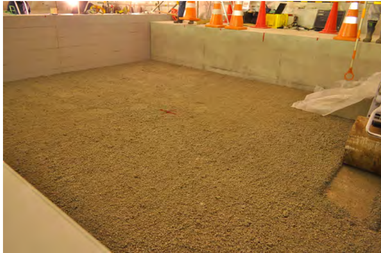
図 3.1-39 敷均し完了後の状況
