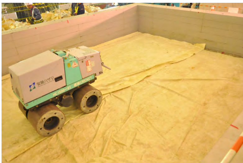
図 3.1-52 シート養生状況
