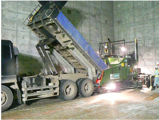
図 3.1-4 大型フィニッシャーによる敷均し
