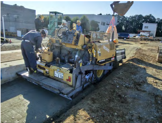
図 3.1-6 小型フィニッシャーによる敷均し
