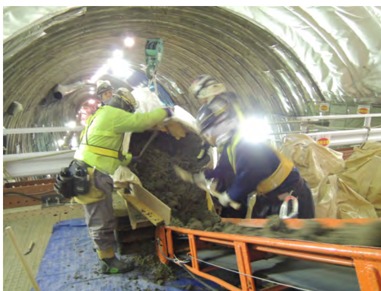
図 5.1-40 材料投入状況
