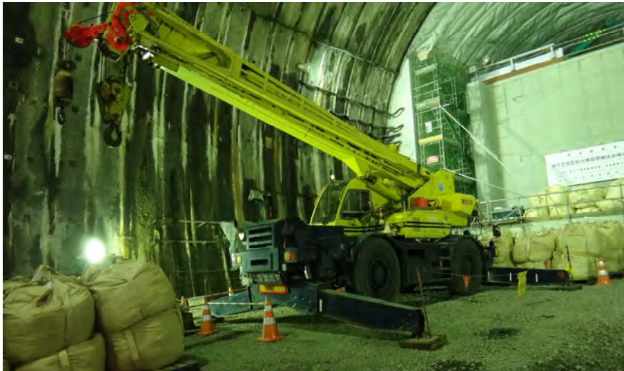
図 3.1-21 25 t ラフタークレーン
