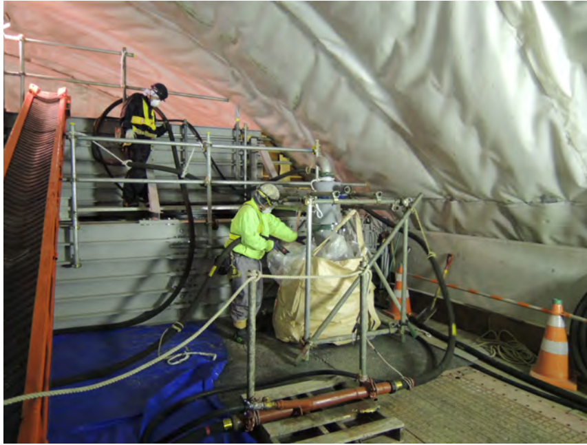
図 3.1-76 ピット上部に設置したサイクロンの様子
