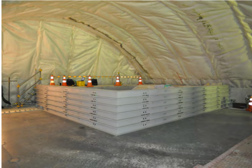
図 3.1-29 型枠設置後の状況（外部）
