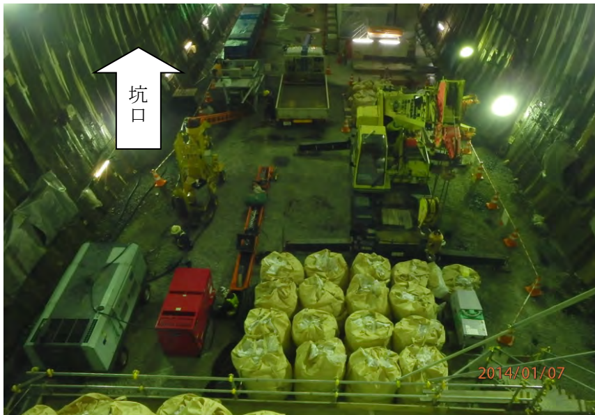
図 5.1-19 コンクリートピット前面ヤード仮置き状況
