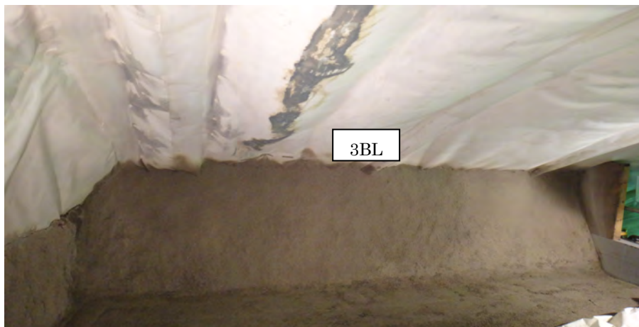
図 5.1-61 3BL 施工終了状況
