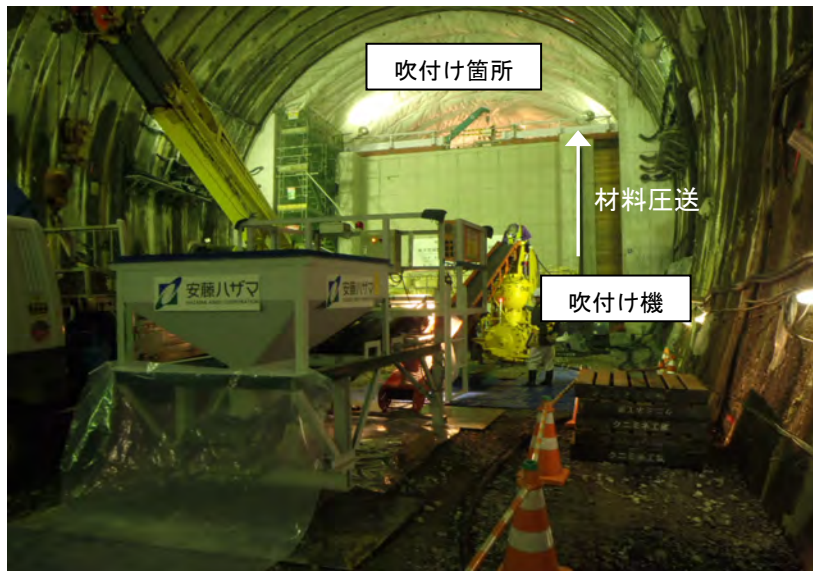
図 5.1-27 吹付け機と吹付け箇所の位置関係
