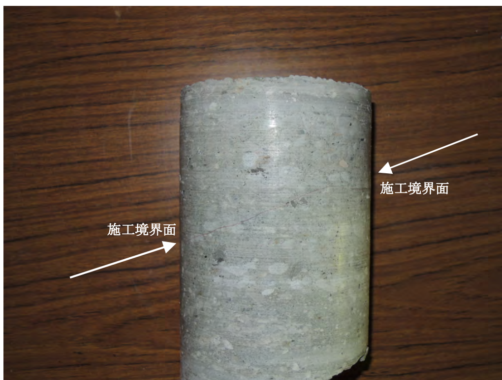
図 3.3-16 施工境界部から採取したコア (目視ではわかりにくいので鉛筆でマーキングしている)
