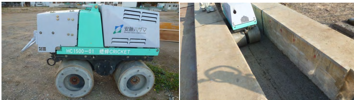
図 4.2-8 小型振動ローラによる施工状況
