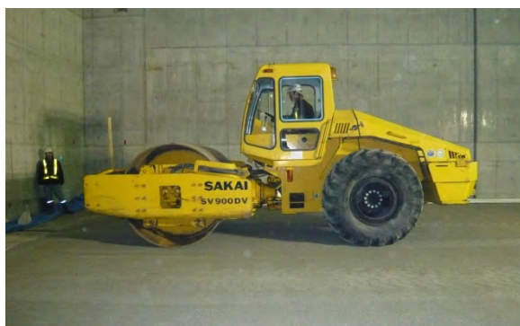
図 3.1-2 大型振動ローラによる施工状況
