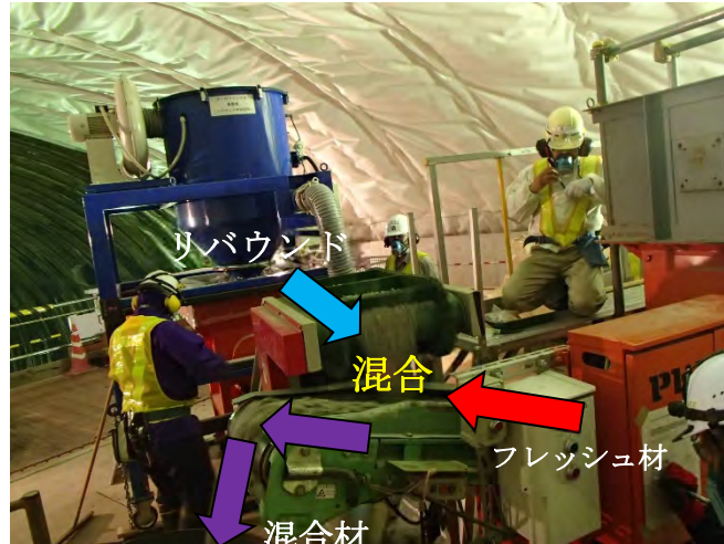
図 2.1-23 フレッシュ材とリバウンド材の混合と供給の様子
