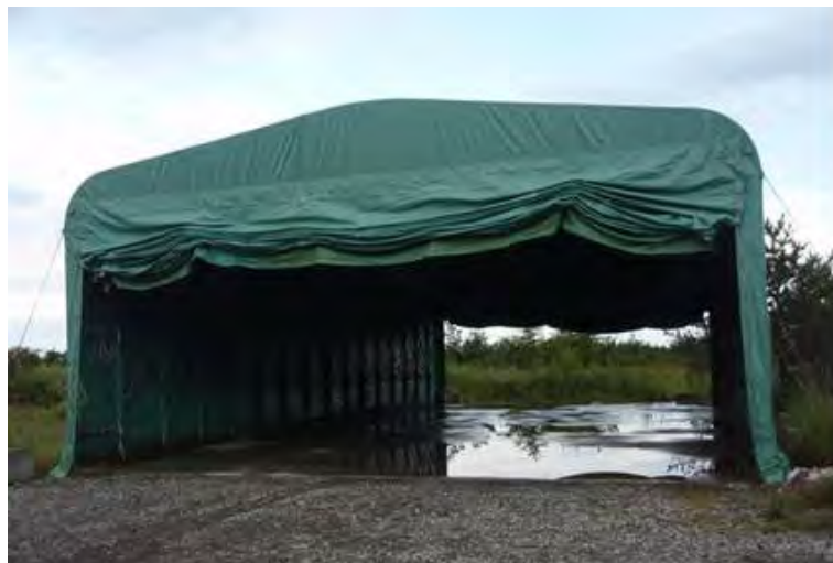
図 3.1-11 ベントナイト保管庫全景
