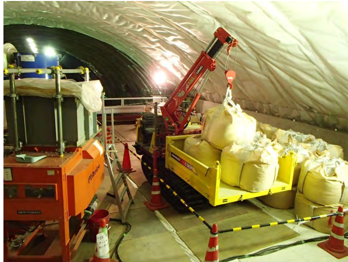
図 2.1-17 ピット上部での材料移動、仮置き状況
