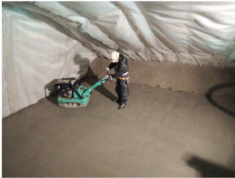
図 5.1-50 振動コンパクタによる転圧状況；縦断方向
