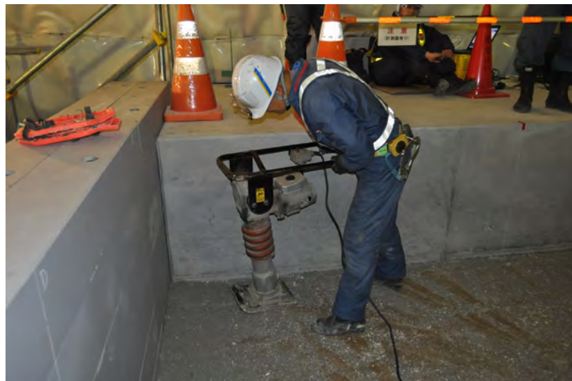
図 3.1-44 ランマによる転圧の状況
