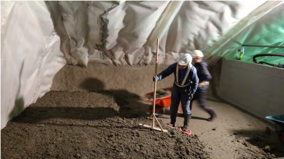
図 5.1-44 レーザーレベルによる敷均し厚さの管理状況
