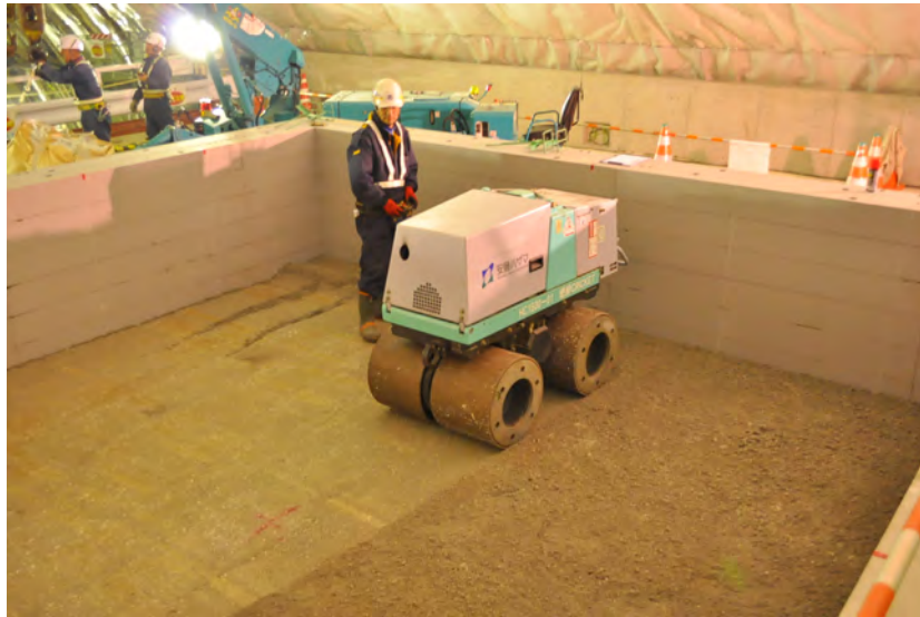
図 3.1-43 小型振動ローラによる無振動転圧の状況
