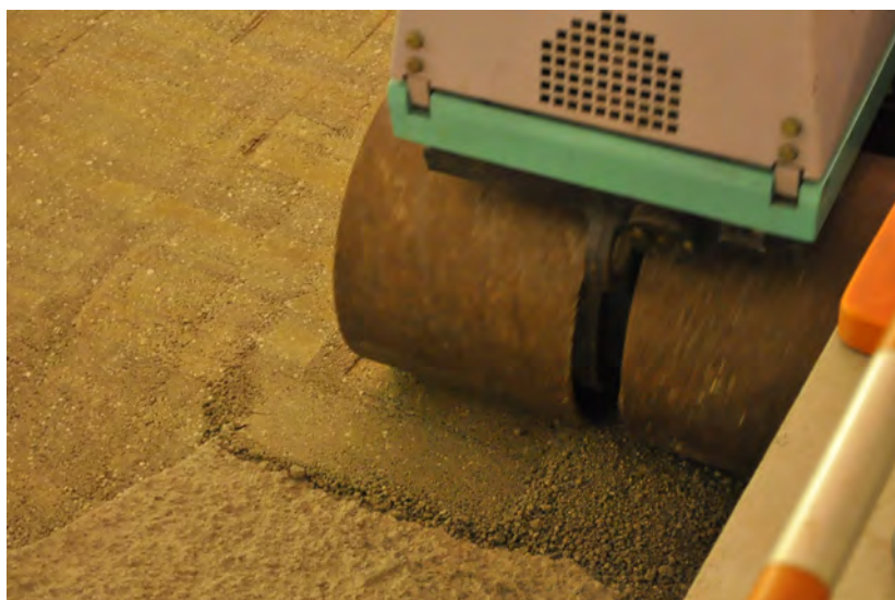
図 3.1-46 吹付け施工により構築された斜路との境界部の転圧状況
