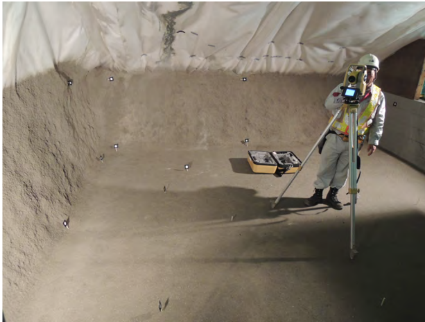
図 5.1-35 トータルステーションによる測量の様子
