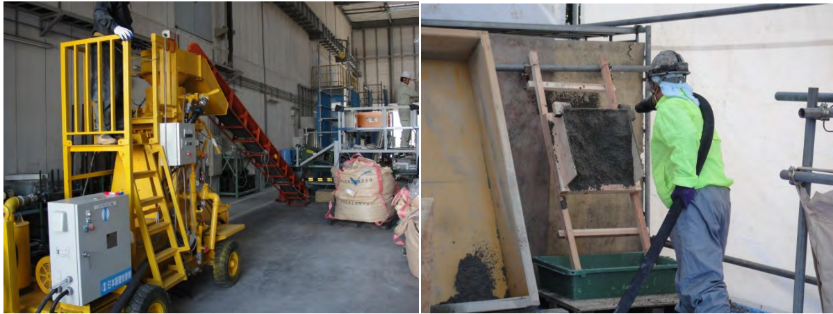
図 4.2-10 吹付け工法による施工状況
