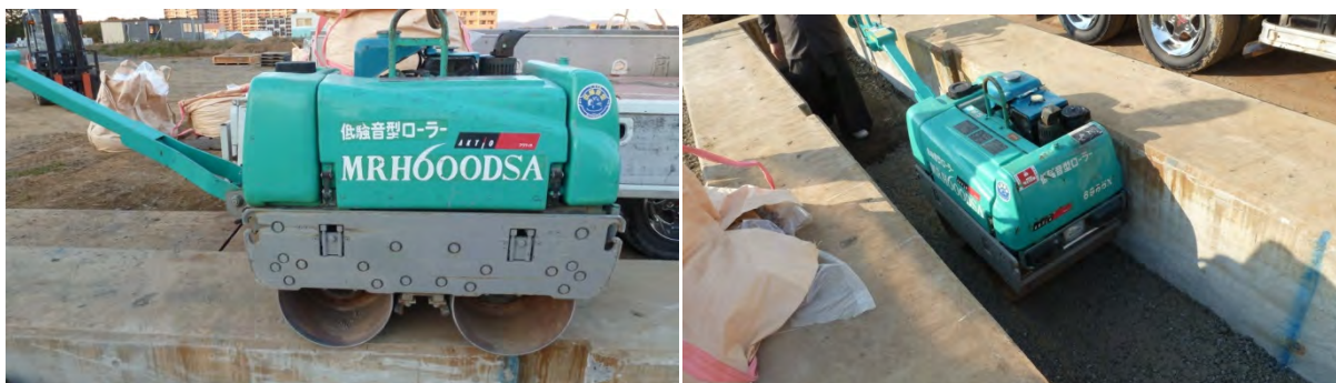
図 4.2-7 ハンドガイド振動ローラによる施工状況
