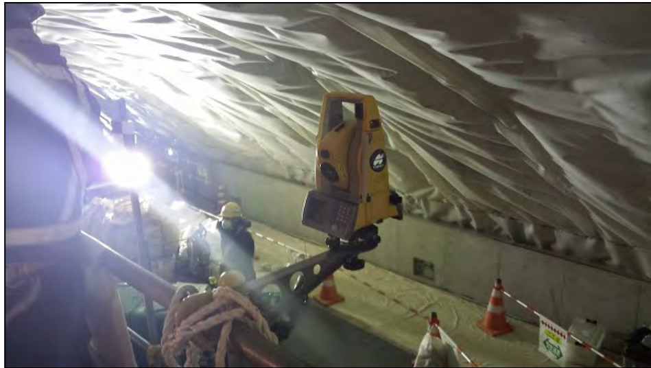
図 5.3-31 トータルステーションの固定状況
