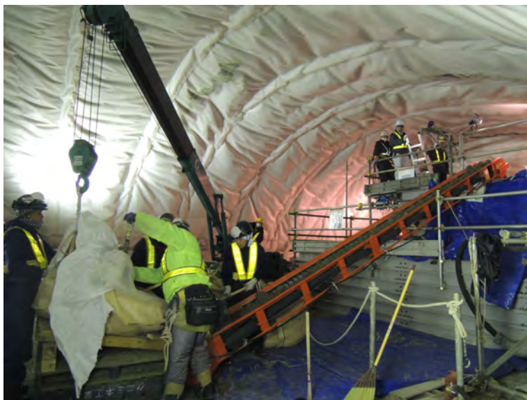
図 5.1-39 材料投入状況
