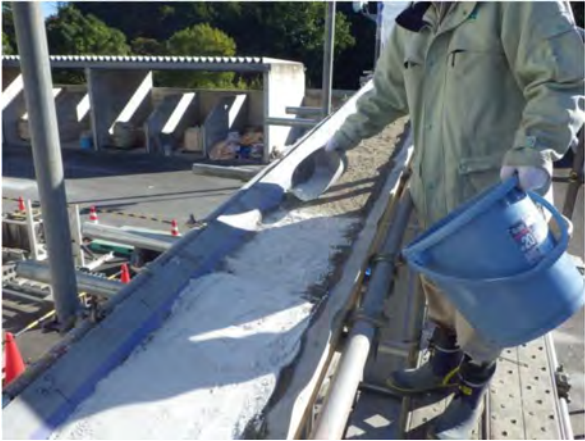
(a) 人力敷均し
