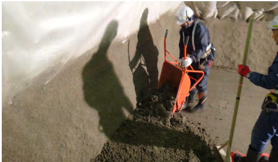
図 5.1-42 材料の敷均し状況
