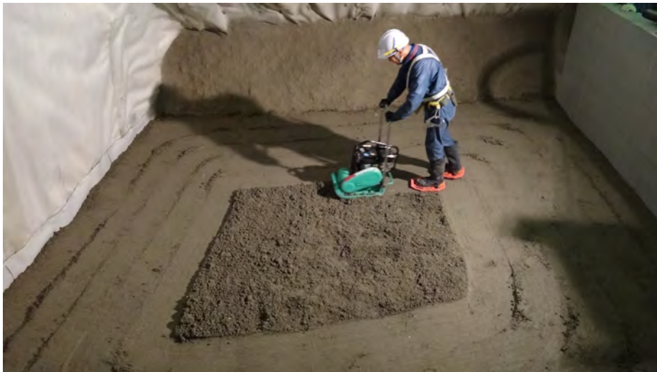
図 5.1-47 予備転圧状況
