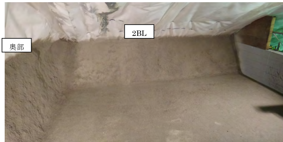
図 5.1-60 2BL 施工終了状況
