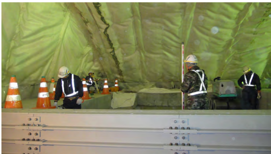
図 3.1-48 レベル測量の状況
