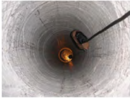
a) Empty borehole SB2
