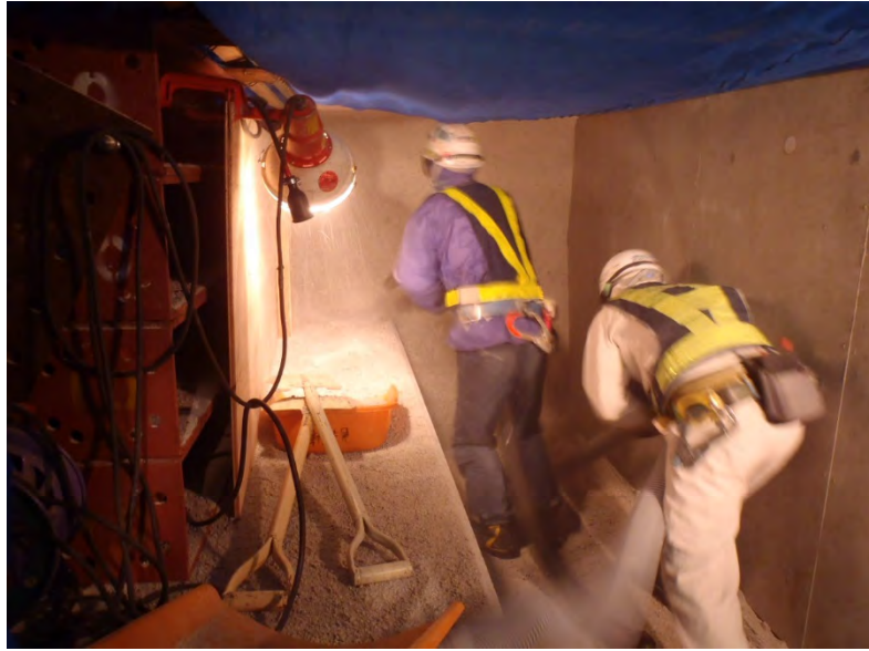
図 2.1-21 吹付け施工およびリバウンド材吸引回収状況
