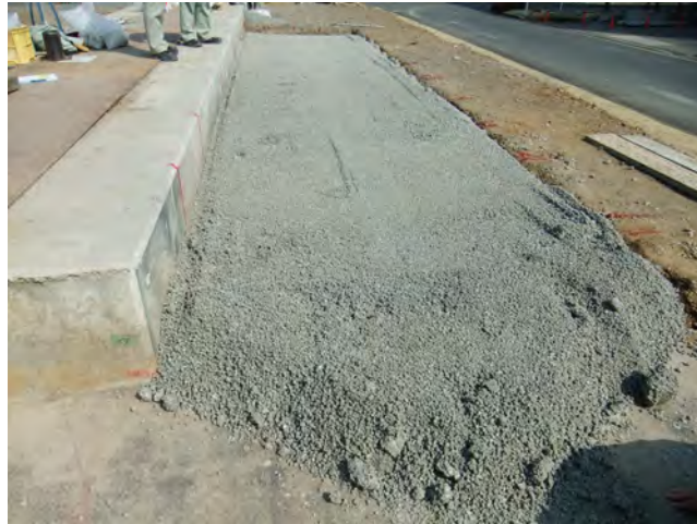
図 5.1-3 小型フィニッシャーによる敷均し結果
