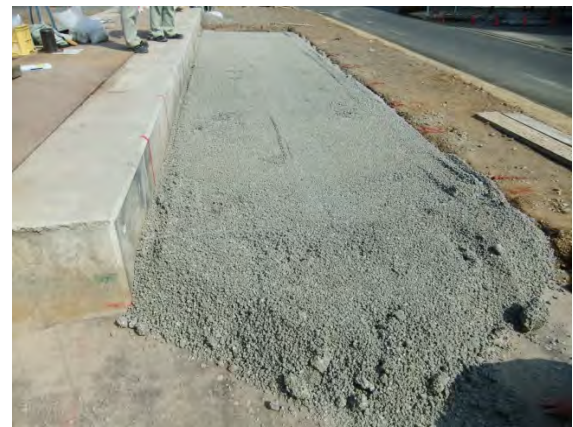
図 3.1-7 小型フィニッシャーによる敷均し
