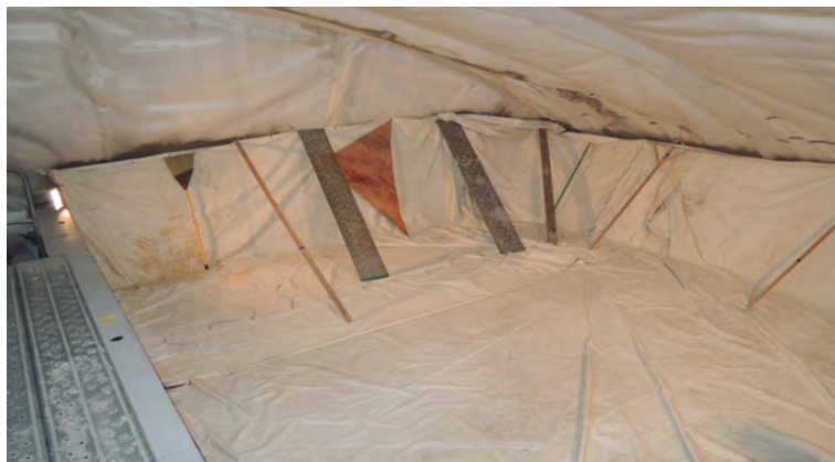
図 5.1-55 シート養生状況
