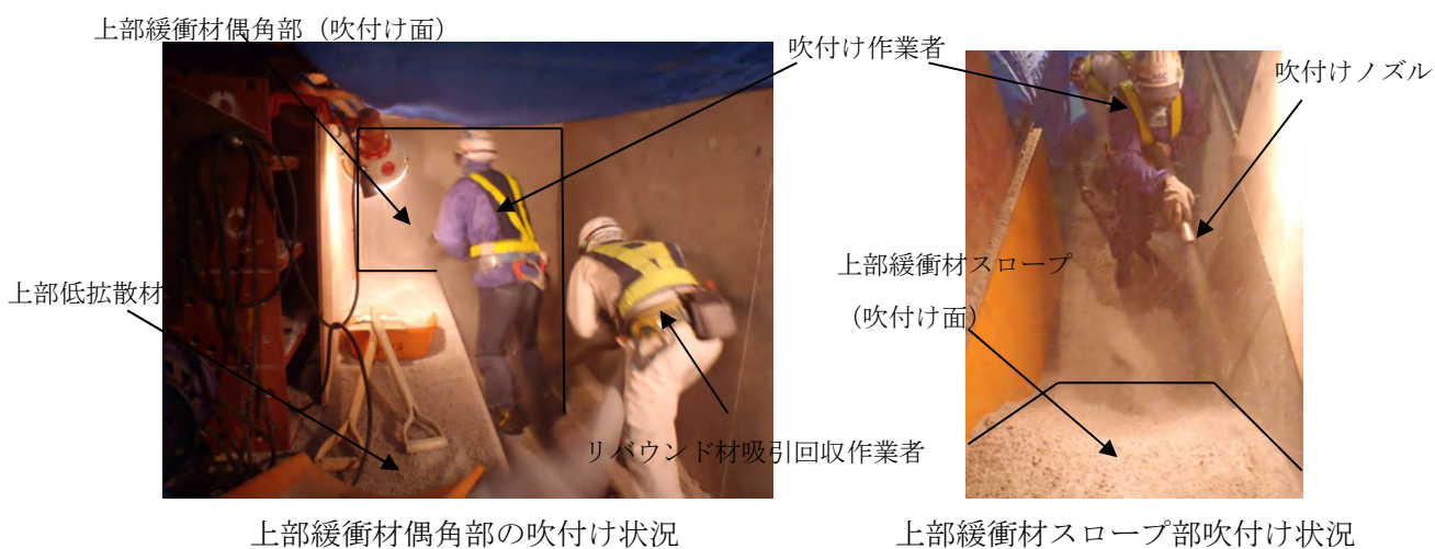
図 1.3-2 上部緩衝材隅角部施工試験状況
