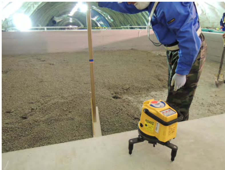
図 3.1-37 レーザーレベルによる敷均し厚さの管理状況
