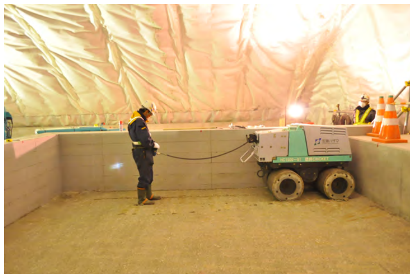
図 3.1-45 小型振動ローラによる振動転圧の状況
