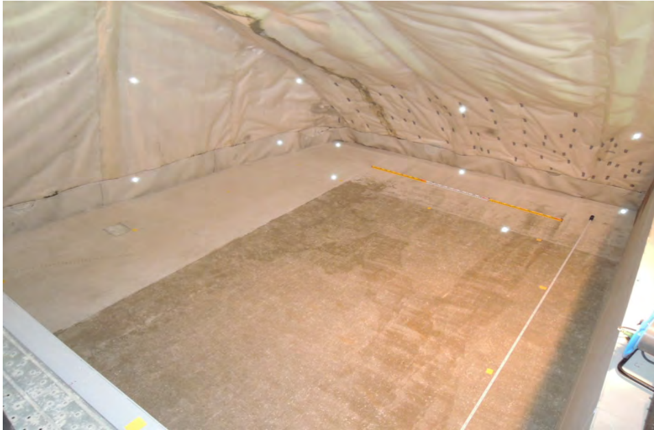
図 5.1-24 型枠設置後内部の状況
