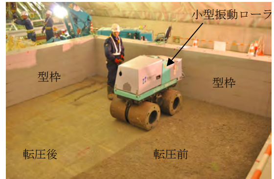
小型振動ローラによる転圧状況
