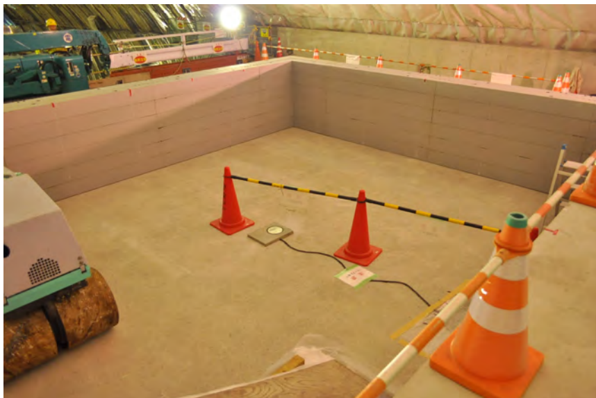
図 3.1-30 型枠設置後の状況（内部）
