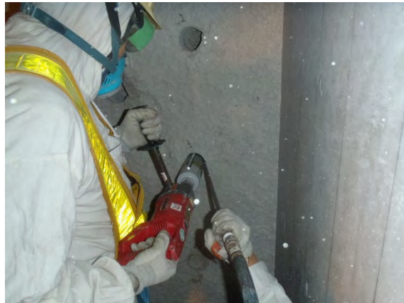
図 2.2-4 ハンディコアドリルによるコア抜き
