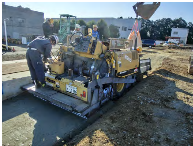
図 5.1-2 小型フィニッシャーによる敷均し
