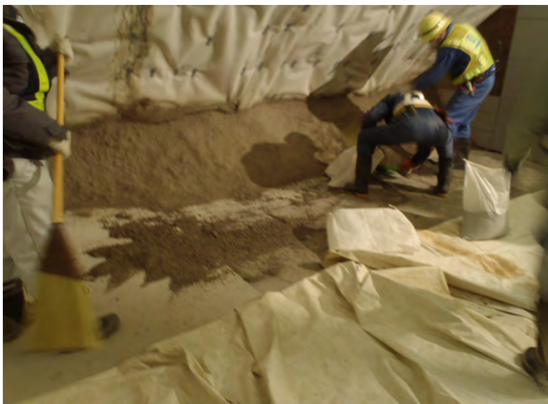
図 5.1-32 リバウンド材回収状況
