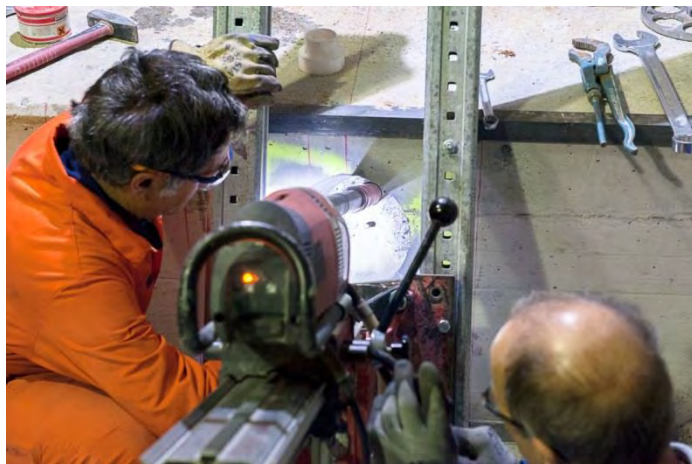
図 2.1.4-23 安定孔を掘削している状況
