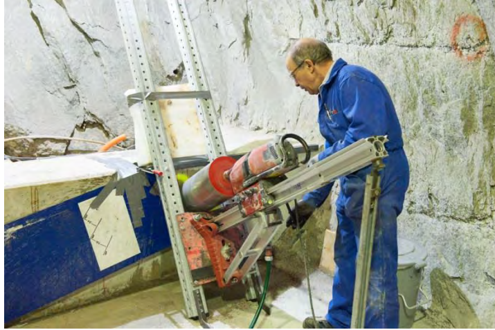
図 2.1.4-22 安定孔を掘削している状況
