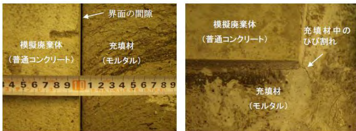
図 3.2.1-7 充填材の隙間とひび割れ[45]
