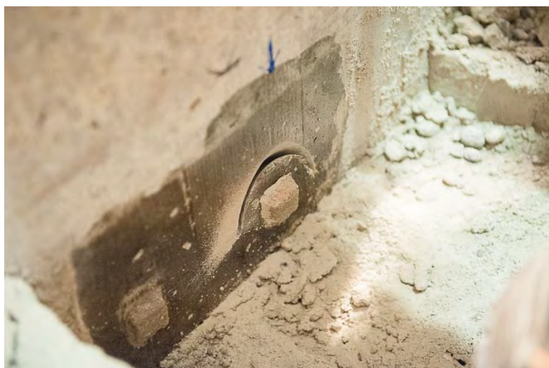
図 2.1.4-10 ボーリングマシンにより掘削した直後の状況
