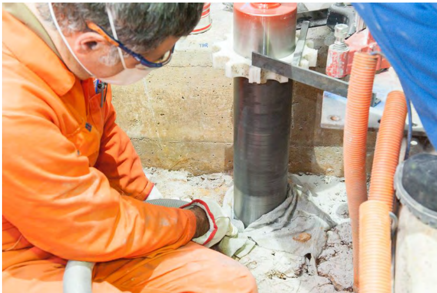
図 2.1.4-29 Box-core-3 コアの掘削状況
