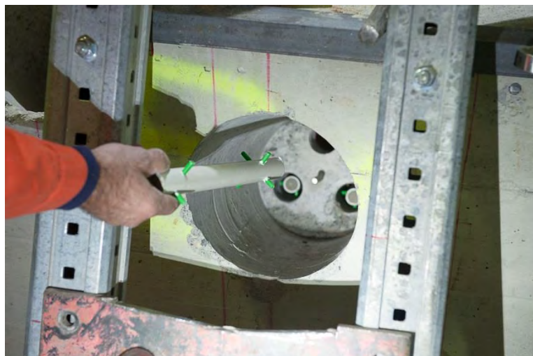
図 2.1.4-24 先行した3本の安定孔に、孔壁安定用のロッドを挿入している状況
