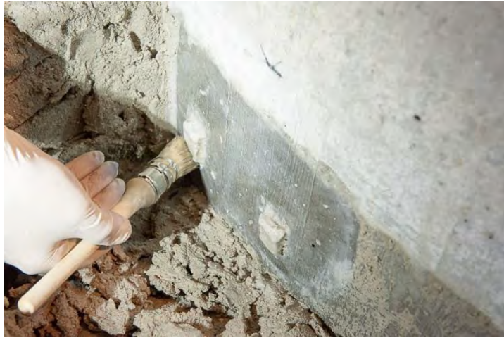
図 2.1.4-8 レジンを塗布しベントナイト混合土をサイロコンクリートの表面に固定している状況
