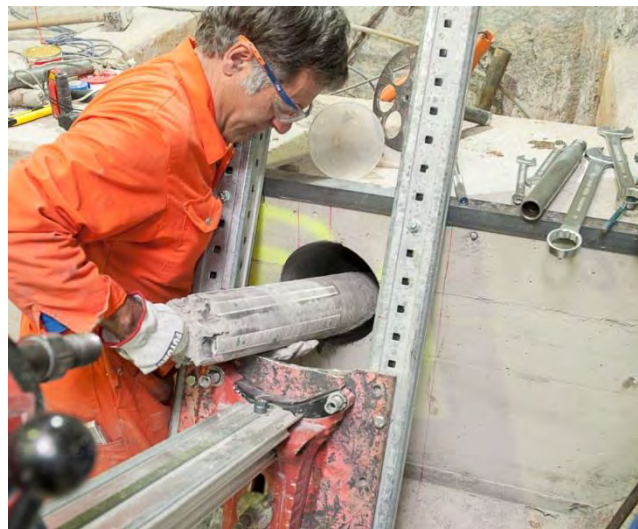
図 2.1.4-26 Box-core-2 を取り出している状況
