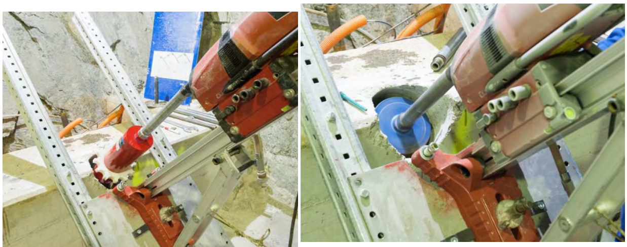
図 2.1.4-16 レジン硬化後、オーバーコアリングにより試料を採取している状況
