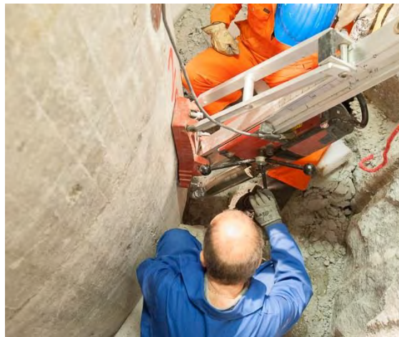
図 2.1.4-9 ボーリングマシンの据付け
