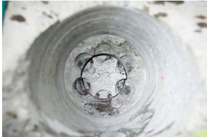
2.1.4-17 オーバーコアリングしたコア試料を取り出す前の状況
