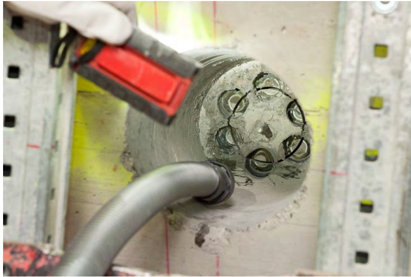
図 2.1.4-25 オーバーコアリング後の孔内の状況
