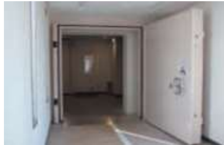
津波時の浸水防止のための水密扉 (東北電力・東通原発)
