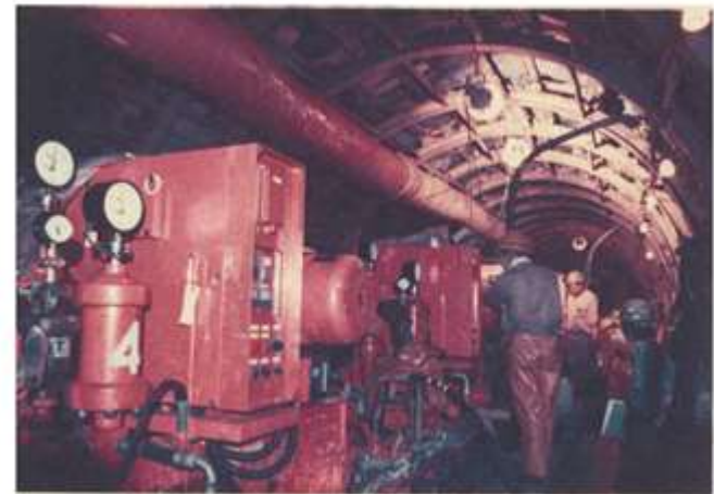
湧水を抑制するためのグラウト施工の様子 (秋田, 2011)
