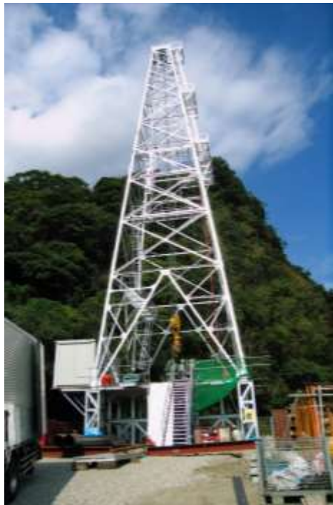
ボーリング調査
