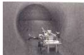
坑道の掘削イメージ
