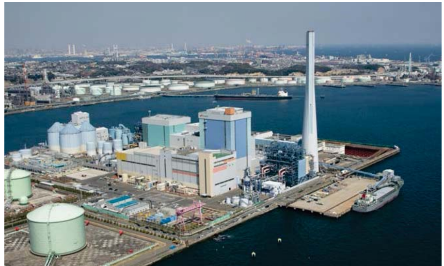
【高効率石炭火力発電所の例】 (磯子火力発電所)
