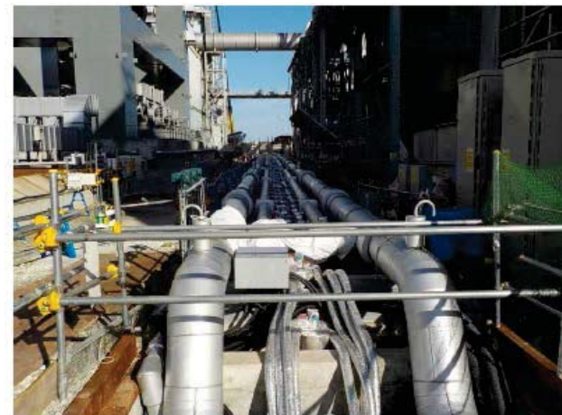
4号機建屋南側 施工完了状況
