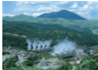
八丁原地熱発電所(大分県九重町)
