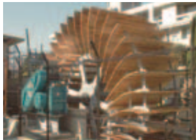
家中川小水力市民発電所(山梨県都留市)
