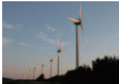
能代風力発電所(秋田県能代市)
